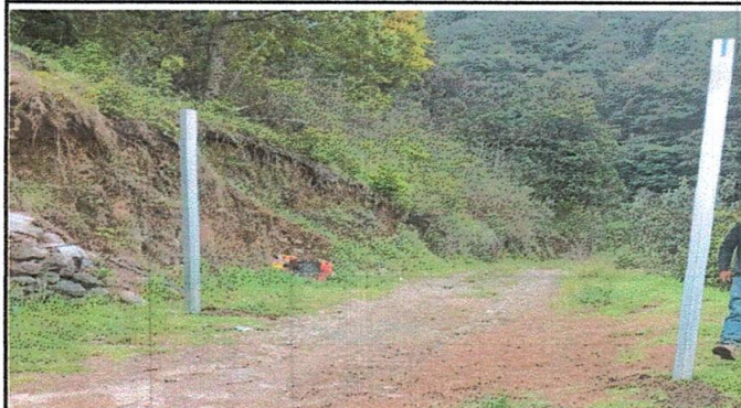
Foto 2: Mejoramiento de porton de metal de 5.50 metros de ancho por 2 metros de alto
