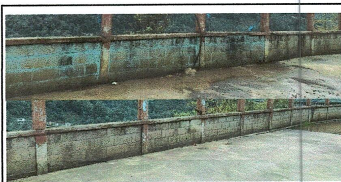
Foto 5: Reparación de muro perimetral de block
