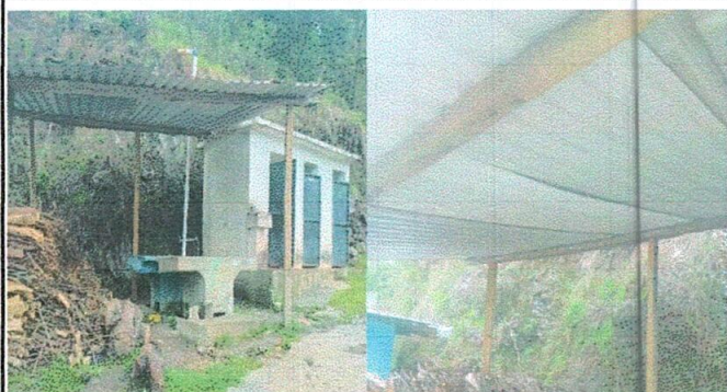
Foto 1: Sustrucción de estructura de soporte de madera por metal y Sustrucción de lámina, por lámina troquelada aluzinc calibre 26
