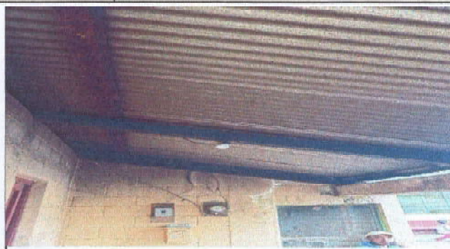
FOTO 2: SUSTITUCION DE ESTRUCTURA DE TECHO
