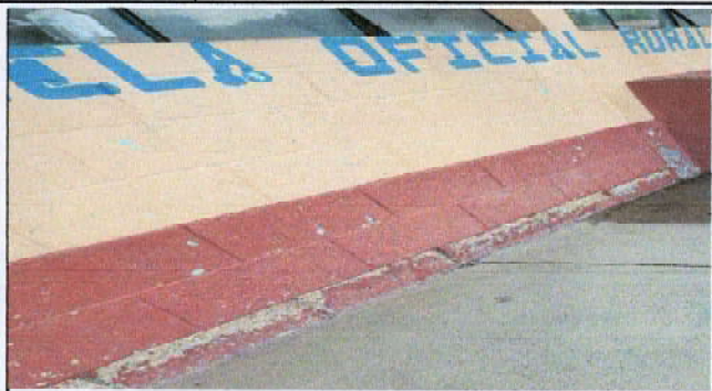
FOTO 7: SUSTITUCION DE PINTURA EN PAREDES INTERIORES Y EXTERIORES
