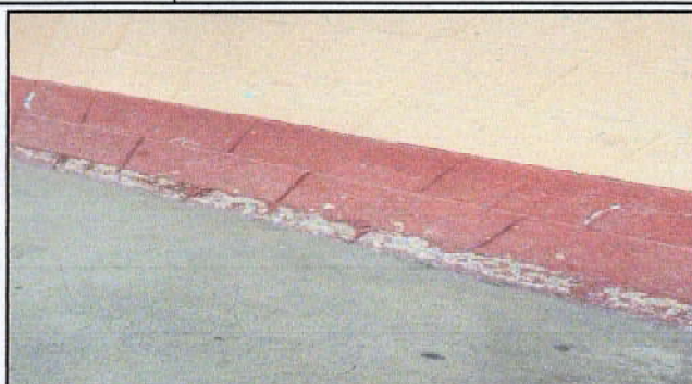
FOTO 8: SUSTITUCION DE PINTURA EN PAREDES INTERIORES Y EXTERIORES
