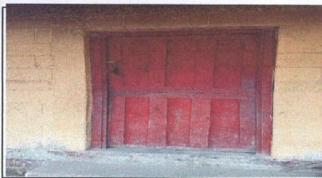
FOTO 5: SUSTITUCION DE PUERTAS
