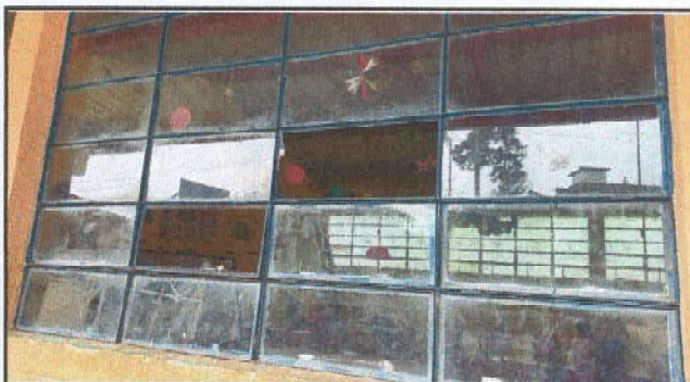
FOTO 3: SUSTITUCION DE VENTANAS
