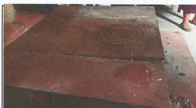
FOTO 6: SUSTITUCION DE PLANCHA
