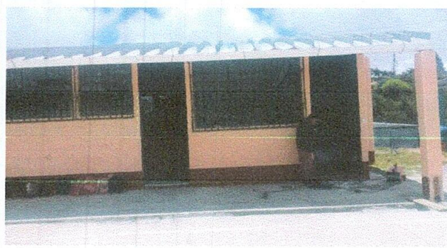
Foto 2: Sustitución de puertas de metal de 1.80 metros de ancho por 2.10 metros de alto
