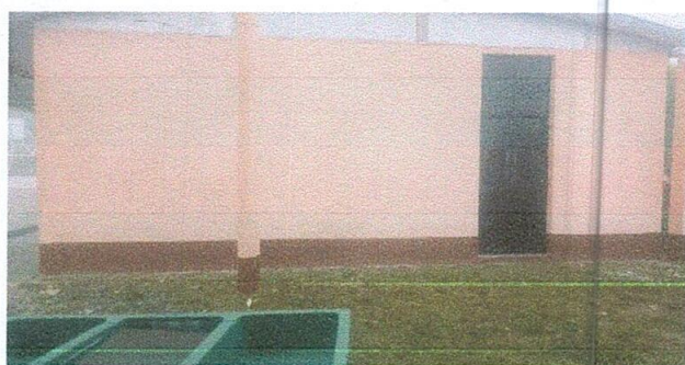
Foto 5: Repello de muro
