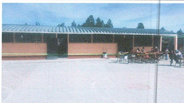
Foto 3: Pintura de muros exteriores e interiores
