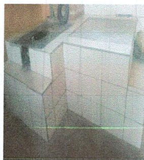
Foto 6: Reparación de cocina
