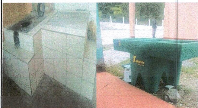
Foto1: Reparación de cocina
