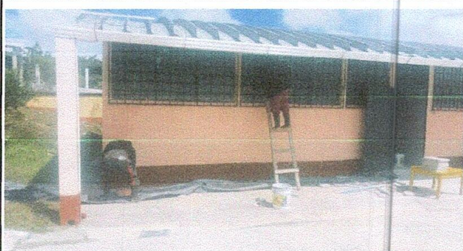
Foto 3: Pintura de muros exteriores e interiores
