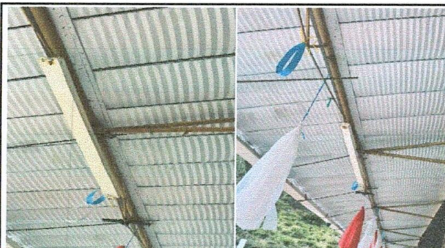
Foto 4: Instalación de unidades de luz (lámpara doble tubo led)
