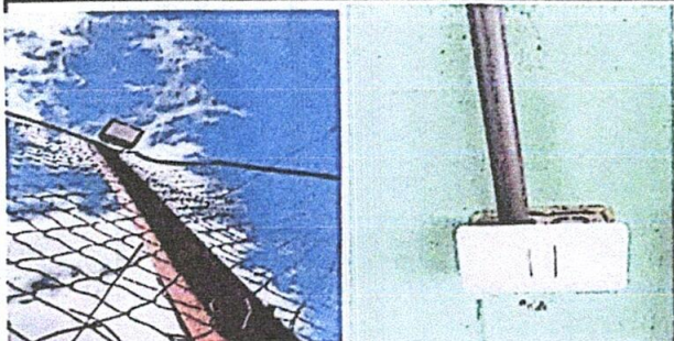
FOTO 3. REPARACIÓN DEL SISTEMA ELECTRICO
