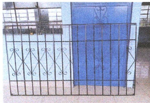
Foto 2: MEJORAMIENTO DE BALCONES DE METAL
