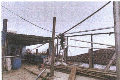
Foto1: SUSTITUCION DE LAMINA POR LAMINA TROQUELADA
