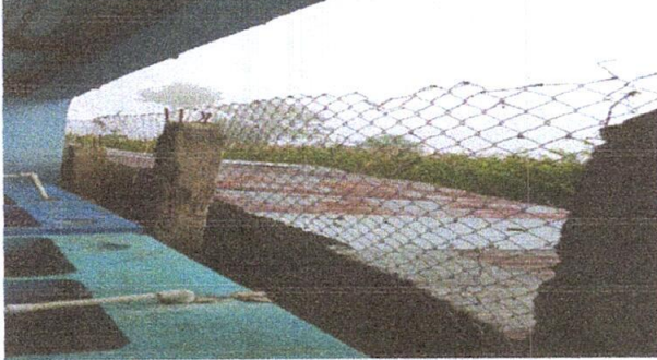
Foto 1: REPARACION DE TUBO HG Y MALLA GALVANIZADA
