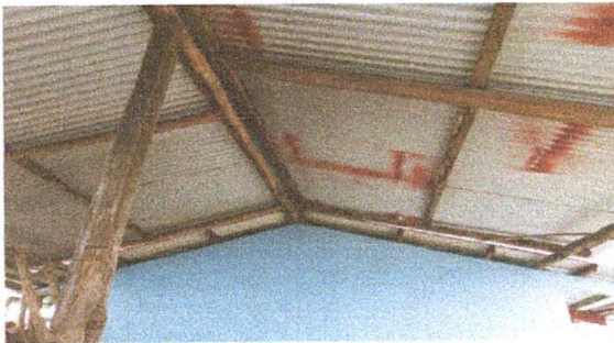
FOTO 3. ESTRUCTURA DE TECHO
