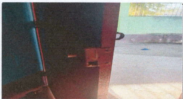
FOTO 5: SUSTITUCION DE PUERTA DE METAL
