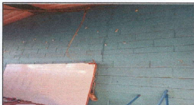
FOTO 3: PINTURA EN MUROS
