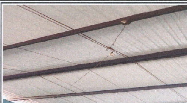
FOTO 2: SUSTITUCION DE PLAFONERAS
