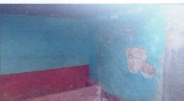
FOTO 6: REPARACION DE REPELLO DE PAREDES
