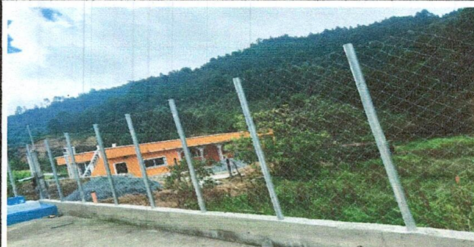
FOTO2: Sustitución de malla galvanizada y tubo HG
