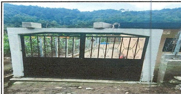
FOTO 5: Sustitución de portón
