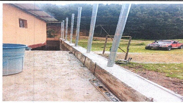
FOTO2: Sustitución de malla galvanizada y tubo HG
