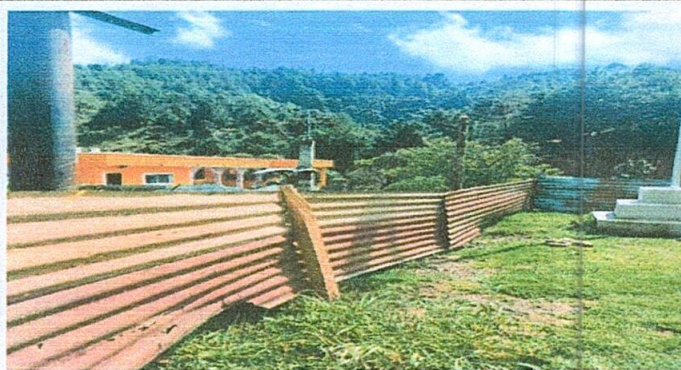
Foto1: Mejoramiento de muro perimetral con malla galvanizada y tubo HG
