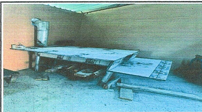
Foto 4: Instalación de azulejo en estufa rural
