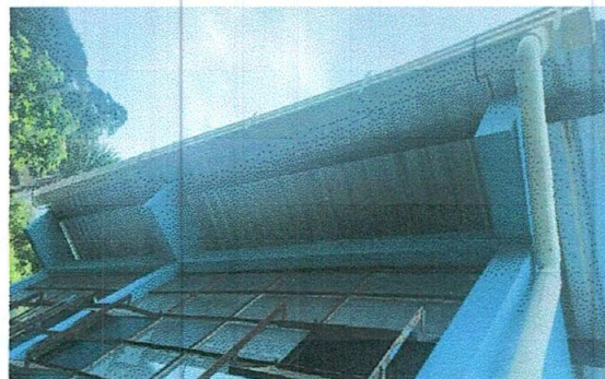
Foto 2: Sustrucción de canales de metal y Sustrucción de bajadas de agua pluvial tubería PVC 3"
