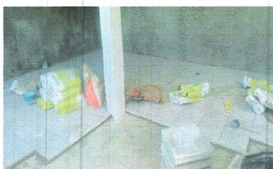
Foto 6: Sustitución de piso de torta de cemento por piso granito
