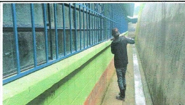
Foto 3: Mejoramiento de balcones para ventanas de metal
