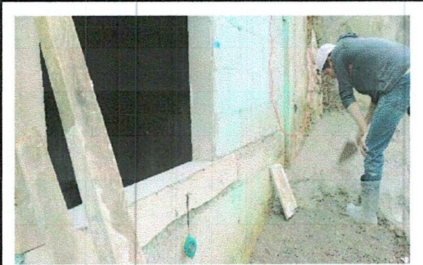
Foto 4: Reparación de planchas de concreto del patio
