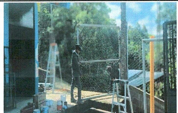
Foto 3: Sustrucción de porton de metal de 4.16 metros de ancho por 2.20 de alto
