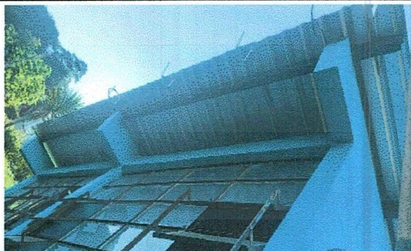
Foto 1: Sustrucción de canales de metal y Sustrucción de bajadas de agua pluvial tubería PVC 3"
