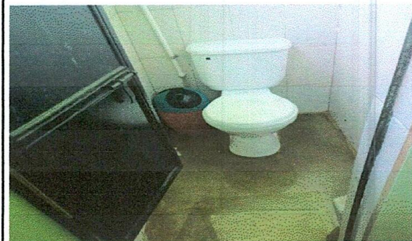
Foto 3: Mantenimiento de puertas de metal para baños
