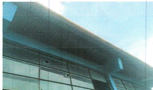
Foto 2: Sustrucción de canales de metal y Sustrucción de bajadas de agua pluvial tubería PVC 3"
