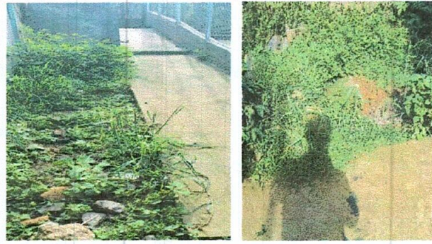
Foto 6: Reparación de planchas de concreto del patio
