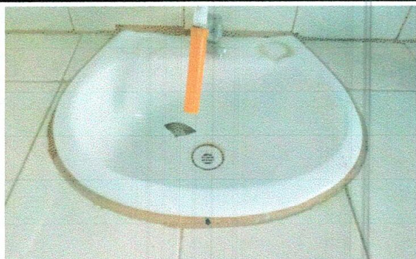
Foto 3: Sustrucción de lavamanos
