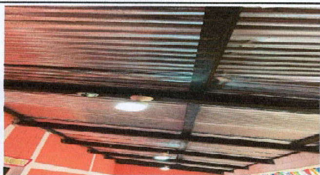
Foto 9: Sustitución de la estructura de madera y lámina del corredor, primer módulo.
