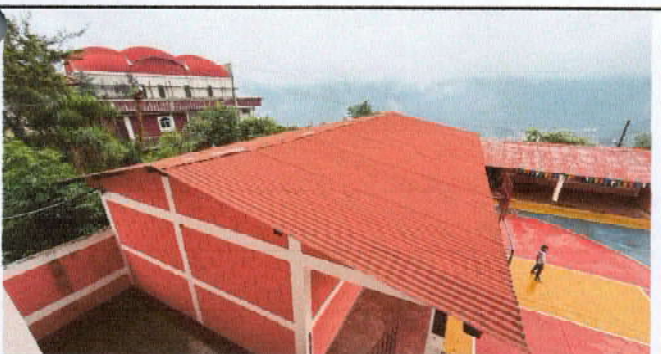
Foto 5: Sustitución de lámina y capote del salón de reuniones.
