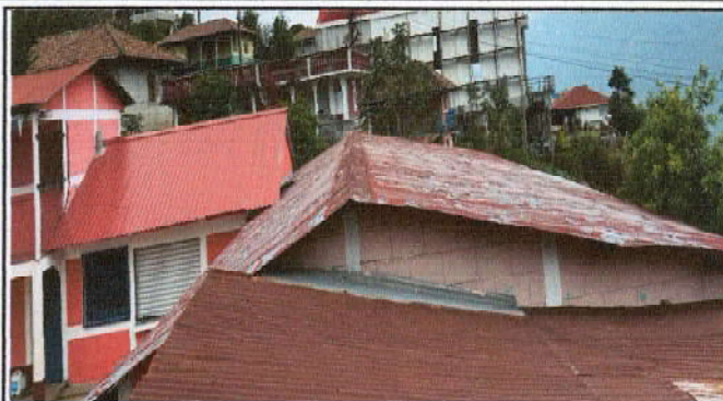
Foto 8: Sustitución de lámina y capote de las dos aulas y corredor del segundo módulo
