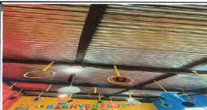
Foto 11: Sustitución de la estructura de madera y lámina de la segunda aula del primero módulo.
