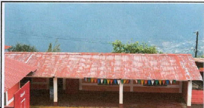
Foto 7: Sustitución de lámina y capote de las dos aulas y corredor del segundo módulo
