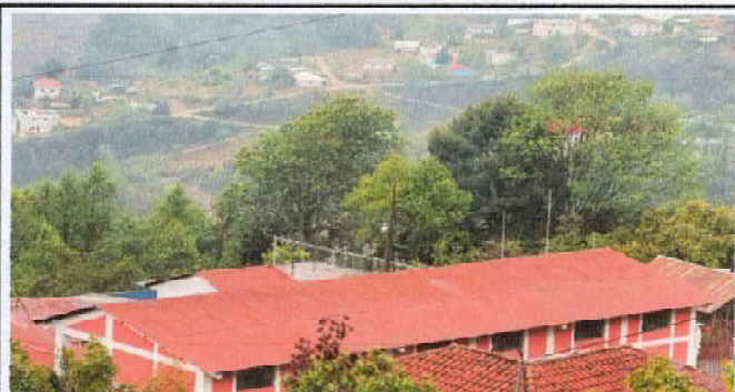
Foto 1: Sustitución de lámina y capote del segundo nivel del primer módulo de clase.
