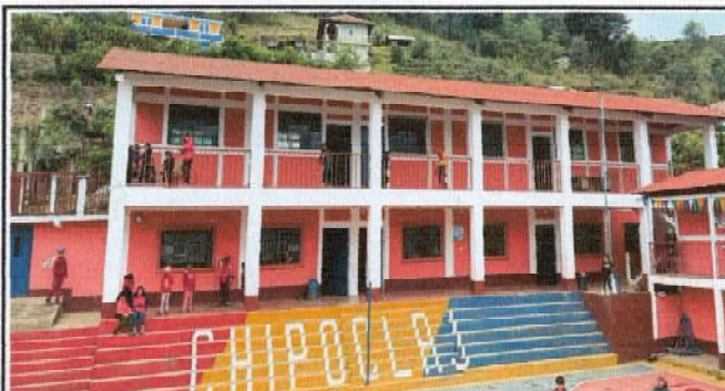
Foto 2: Sustitución de lámina y capote del segundo nivel del primer módulo de clase.
