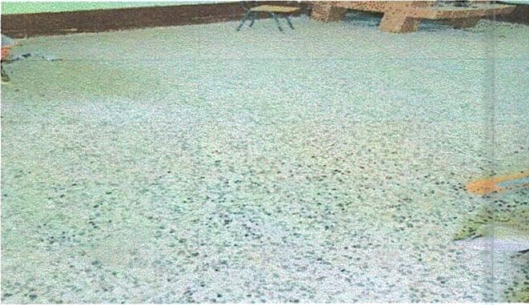
Foto1: Sustrucción de piso de torta de cemento por piso granito
