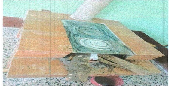
Foto 2: Reparación de cocina
