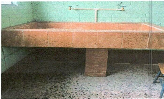
Foto 3: Reparación de cocina
