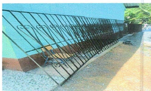
Foto 5: Mejoramiento de balcones de metal
