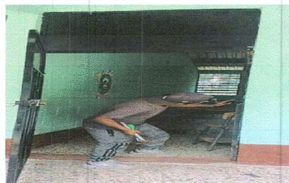
Foto 4: Sustrucción de puerta de metal de 2.10 metros de alto por 1.00 metro de ancho
