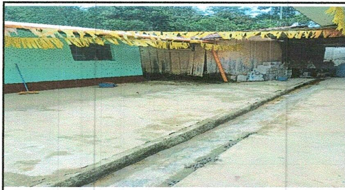
Foto 2: Sustitución de planchas de concreto de patio
