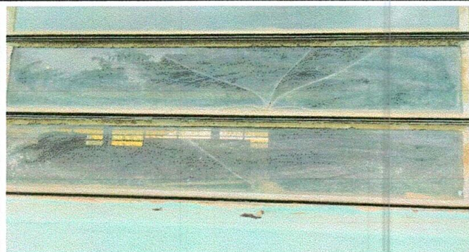
Foto1: Sustitución de vidrios de 31 centímetros de largo por 15.5 centímetros de ancho
