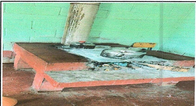
Foto 3: Reparación de cocina
