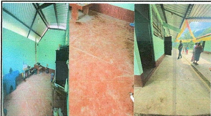
Foto1: Sustitución de piso de torta de cemento por piso granito
