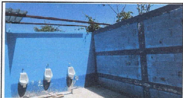
Foto 15: Estructura de techo: sustitucion de lamina por lamina torquelada calibre 26
