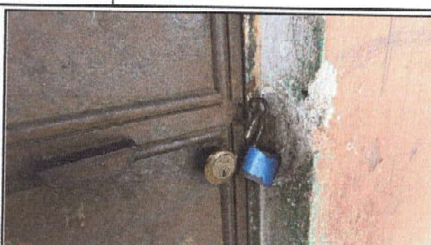
Foto 8: Sustitución de chapas
