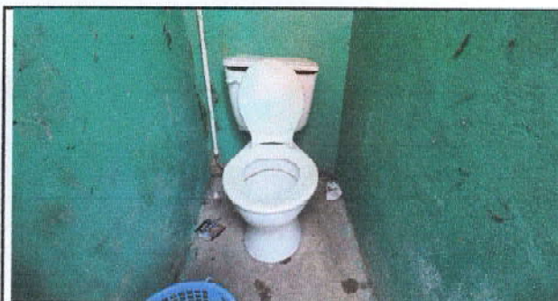
Foto 5: Sustrucción de Inodoros
