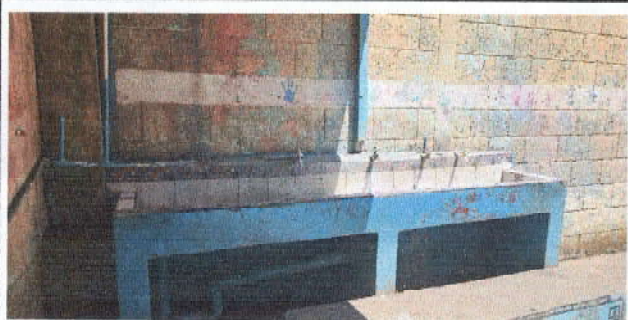
Foto 1: Sustrucción de lava manos de cemento por lavamanos multiusos
