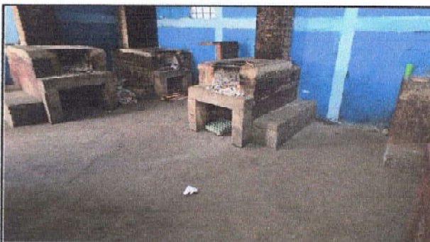
Foto 4: Reparación de Piso: Sustrucción de piso de torta de concreto por piso de granito
