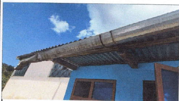
Foto 9: Reparación de Cocina: Sustitución de canal de metal por pvc.
