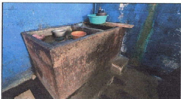
Foto 3: Reparación de Cocina: Sustrucción de pila de cemento de un lavadero por pila de cemento de dos lavaderos
