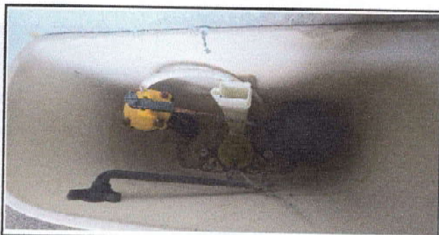
Foto 11: Cambio de Accesorios para Baños
