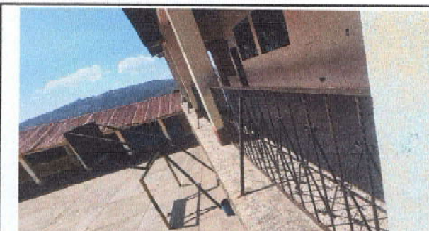
Foto 6: Mantenimiento a barandas de metal
