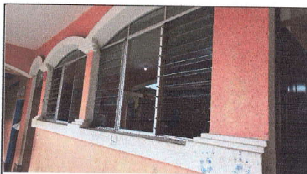
Foto 10: Mejoramiento de ventanas con balcones
