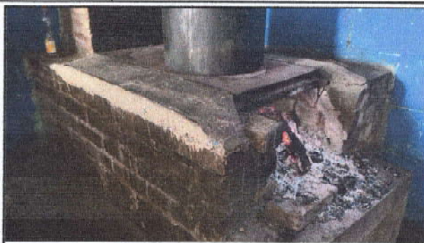
Foto 2: Reparación de Cocina: Sustrucción de Estufa rural Incluye plancha de metal
