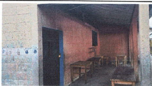
Foto 16: pintura en muro interior y exterior de cosina
