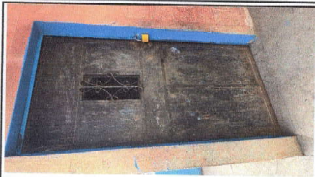
Foto 7: Puertas Metálicas: mantenimiento a estructura (lijado, cepillado, aplicación de pinturas)
