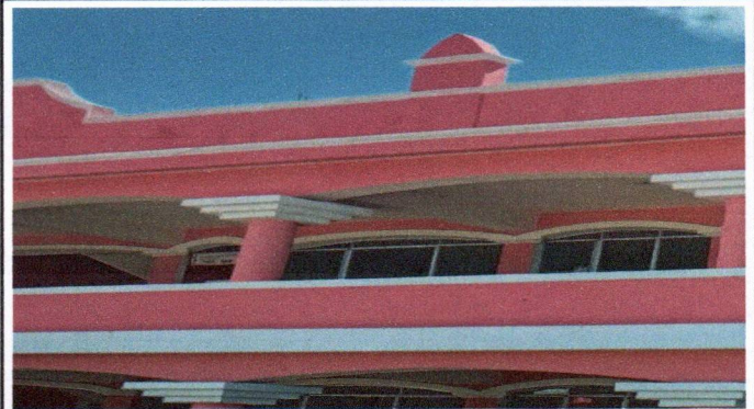
Foto8: Finalizacion de pintura de exteriores aula tres.
