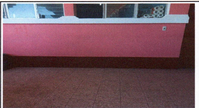
Foto10: finalizacion de pintura de exteriores aula cinco.
