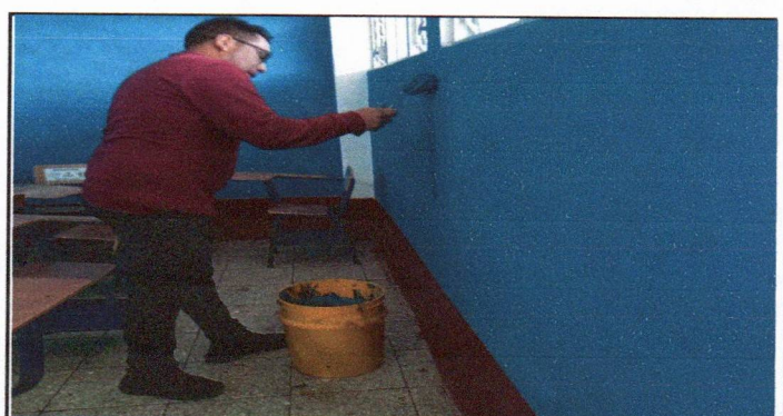
Foto12: Aplicando pintura de interior de aula uno.
