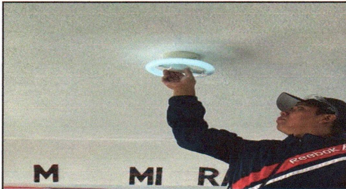
Foto13: sustitucion de foco.
