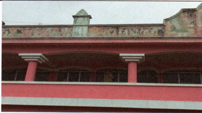
Foto7: Aplicando pintura de exteriores aula dos.
