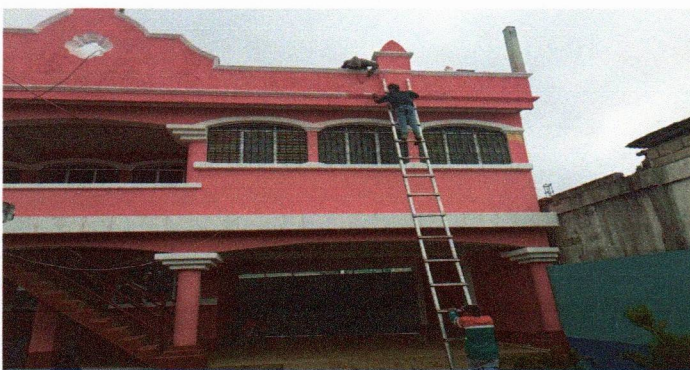
Foto5: Aplicando pintura en exteriores de dirección.
