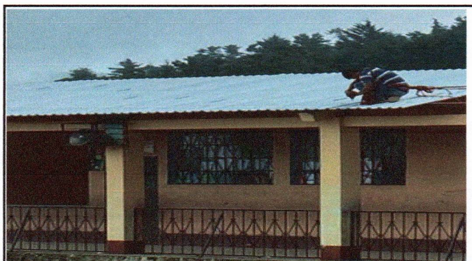
Foto3: colocando elementos de fijacion.
