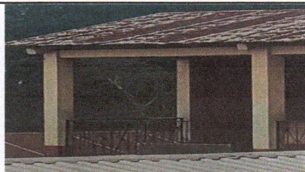
Foto3: Sustrucción de lámina en bodega, por lámina troquelada calibre 26
