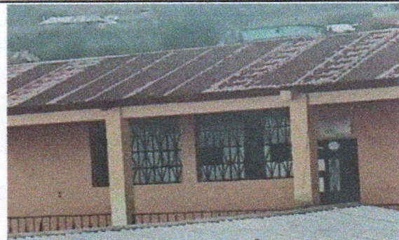
Foto 2: Sustrucción de lámina en aula dos, por lámina troquelada calibre 26
