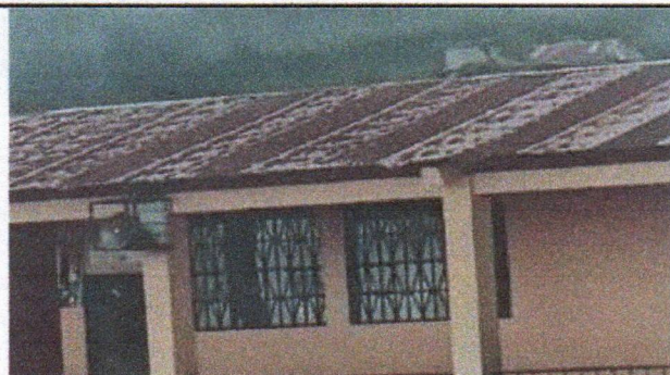
Foto3: Sustrucción de lámina en aula tres, por lámina troquelada calibre 26
