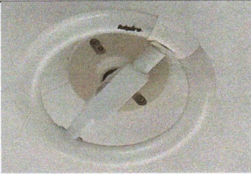
Foto 13: sustitucion de foco
