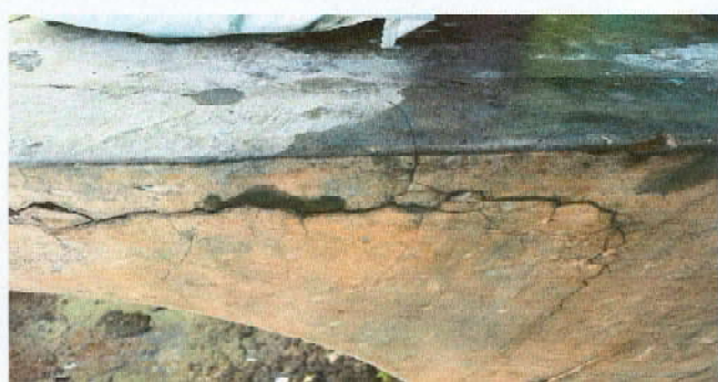
Foto13: Sustitución de pila de cemento de dos lavadores
