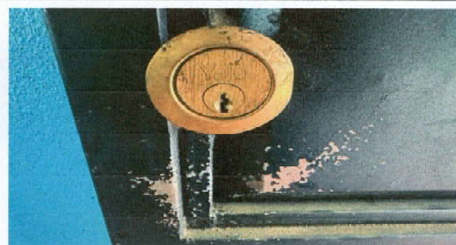
Foto 57: Sustrucción de chapas
