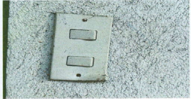
Foto 32: Sustrucción de apagadores dobles
