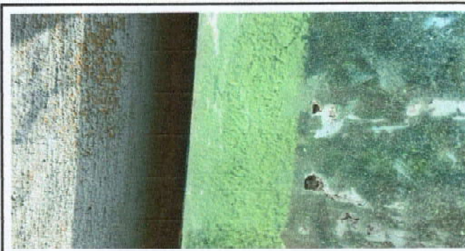
Foto 6: Sustrucción de ventanas
