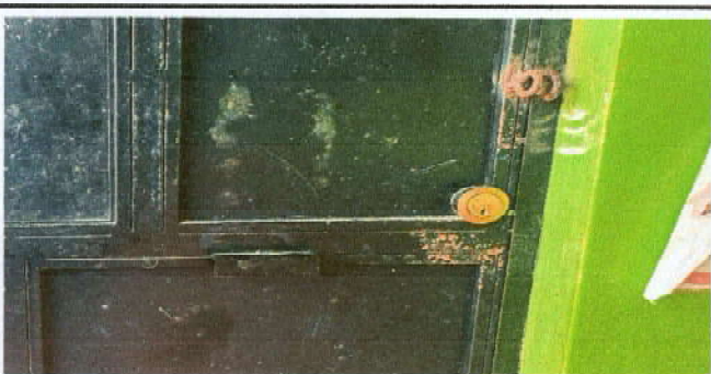
Foto 59: Sustrucción de chapas
