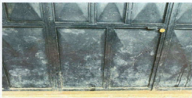
Foto 51: Mantenimiento de puertas
