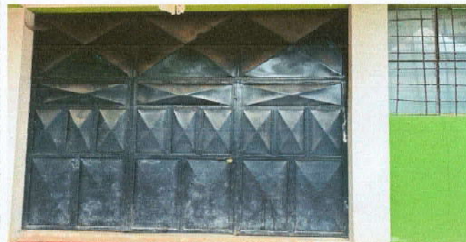
Foto 50: Mantenimiento de puertas
