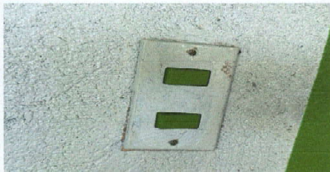
Foto 31: Sustrucción de apagadores dobles
