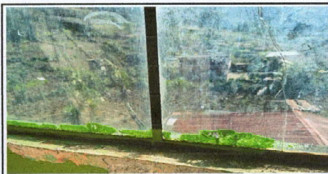
Foto 5: Sustrucción de ventanas
