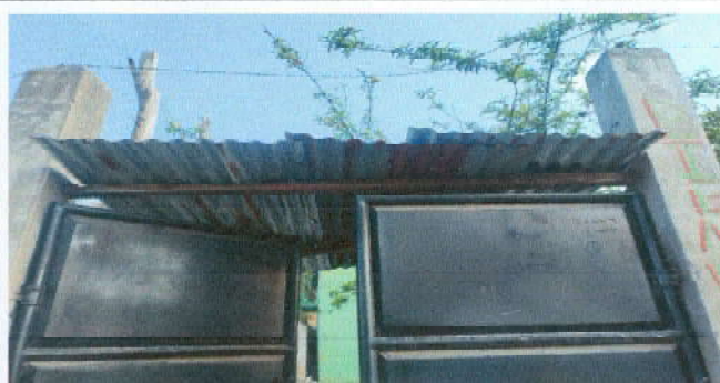
Foto 44: Sustrucción de laminas
