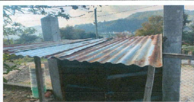
Foto 46: Sustrucción de laminas
