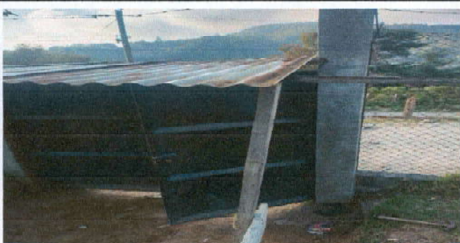
Foto 45: Sustrucción de laminas
