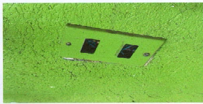
Foto 35: Sustrucción de tomacorrientes
