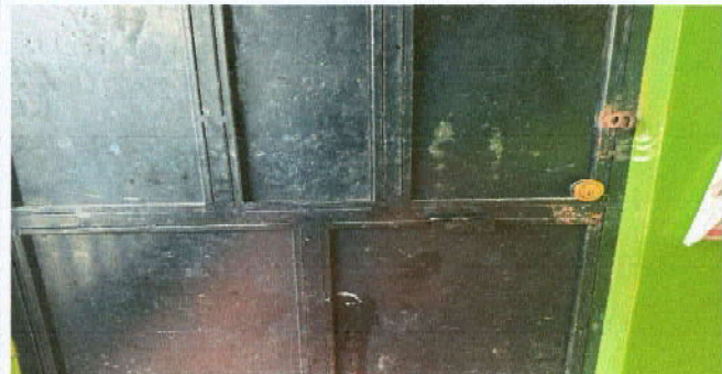
Foto 52: Mantenimiento de puertas
