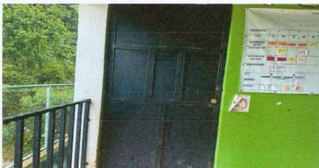
Foto 49: Mantenimiento de puertas
