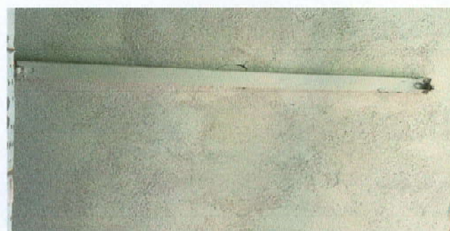
Foto 29: Sustrucción de plafoneras
