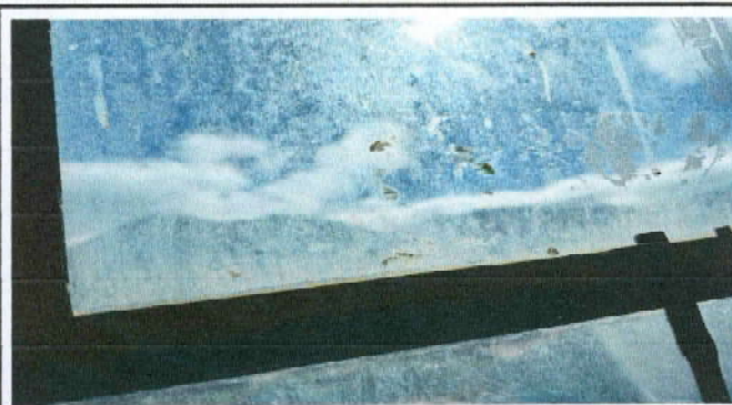
Foto 2: Sustrucción de ventanas
