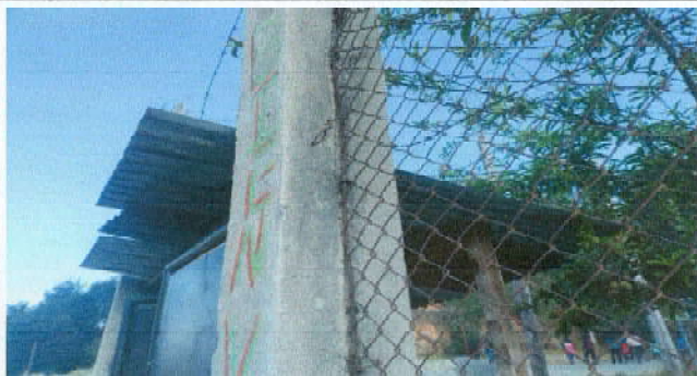
Foto 43: Sustrucción de laminas
