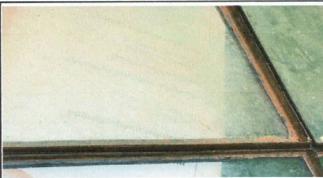
Foto 4: Sustrucción de ventanas
