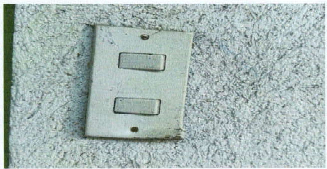
Foto 33: Sustrucción de apagadores dobles
