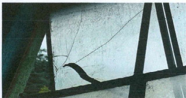
Foto 7: Sustrucción de vidrios de ventanas
