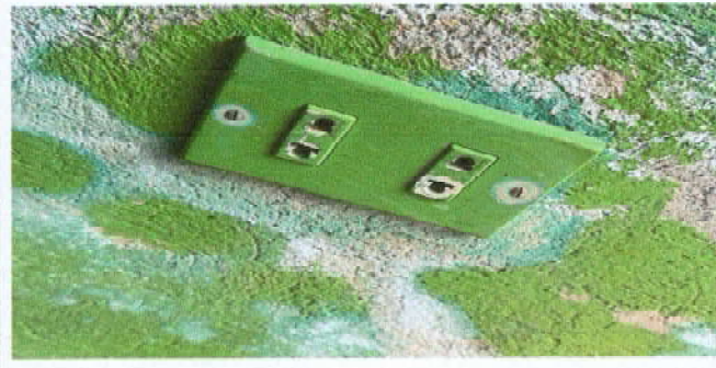
Foto 36: Sustrucción de tomacorrientes
