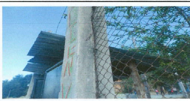
Foto 48: Sustrucción de laminas
