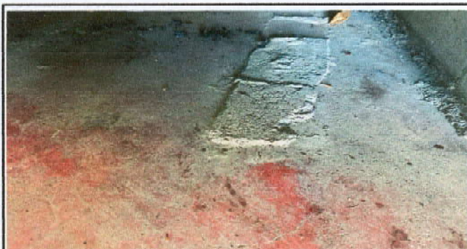
Foto 21: Sustrución de pisos
