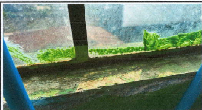
Foto 1: Sustrucción de ventanas
