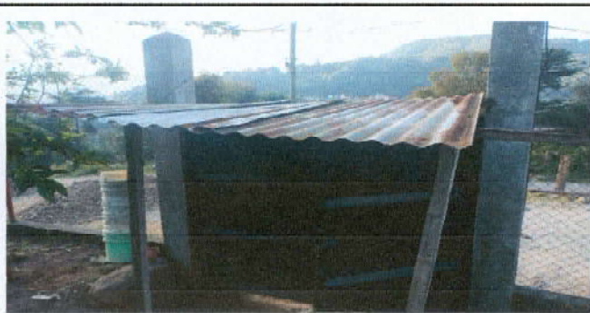
Foto 47: Sustrucción de laminas
