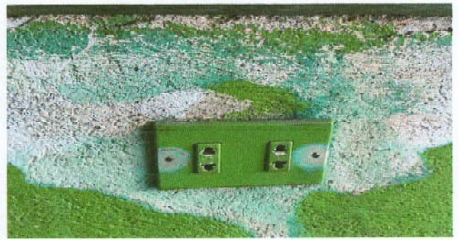
Foto 34: Sustrucción de tomacorrientes
