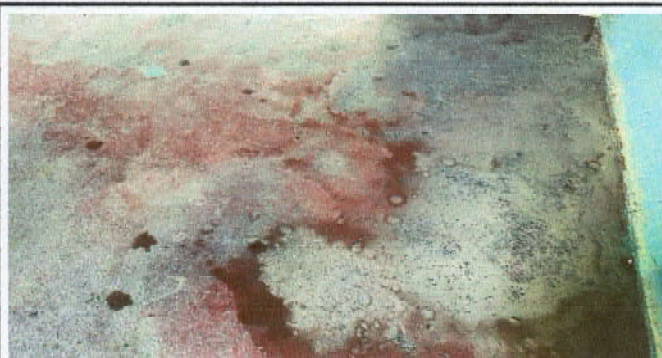
Foto 19: Sustrución de pisos
