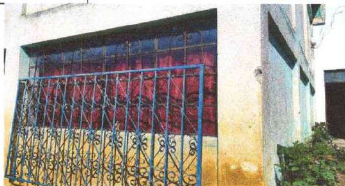
Foto 8: Ventanas: Sustitución de valcones de metal.
