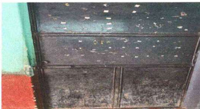
Foto 3: Puertas de metal: Mantenimiento a estructura (lijado, aplicación de pintura) 245cm x 97cm.
