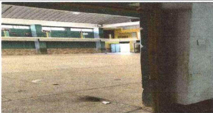
Foto 7: Puertas de metal: Sustitución de portón de madera por metal 144cm x 264cm.
