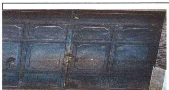
Foto 5: Puertas de metal: mantenimiento de portón (lijado, aplicación de pinturas) 254cm x 300cm.
