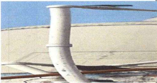
Foto 15: Reparación de red de drenaje y red de agua potable: sustitución de tubería de PBC.
