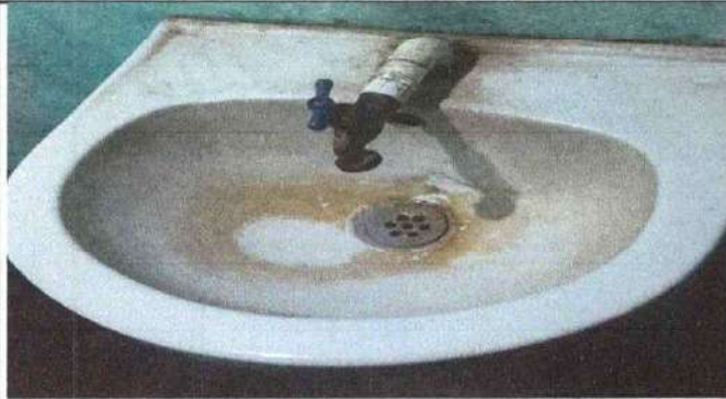
Foto 13: Servicios sanitarios y sus accesorios: sustitución lavamanos.
