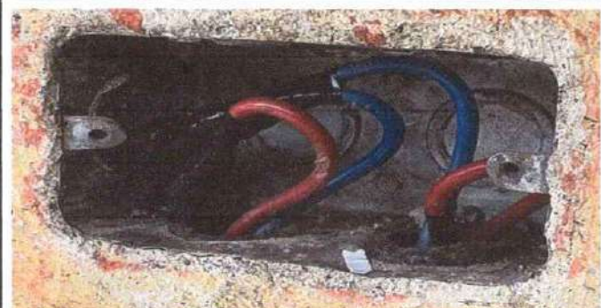
Foto 16: Reparación de sistema eléctrico: sustitución de interruptores dobles.
