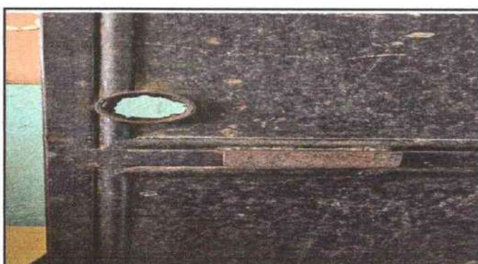
Foto 4: Puertas de metal: Sustrucción de chapas
