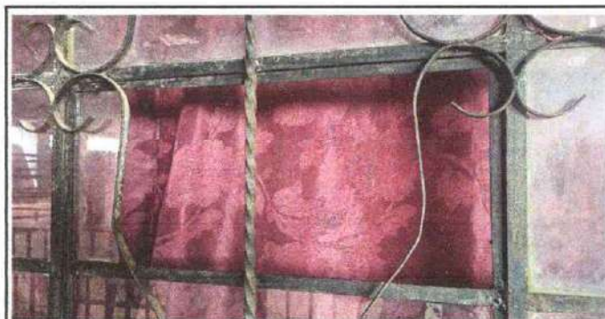
Foto 9: Ventanas: Sustitución de vidrio 58cm x 28cm
