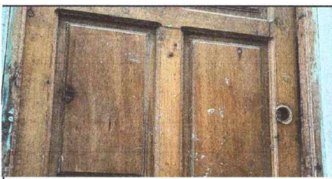
Foto 6: Puertas de metal: Sustrucción de puertas de madera por metal
