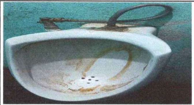
Foto 14: Servicios sanitarios y sus accesorios: Sustitución de mingitorio.
