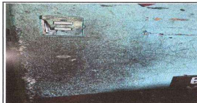
Foto 10: Pinturas en muros exteriores e interiores: pintura interior de aulas.
