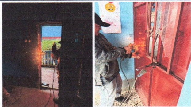
Foto1: Sustitución de puerta de madera por metal + sustitución de chapa
