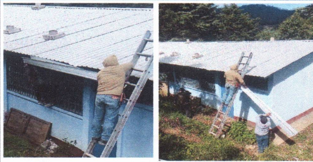
Foto 4: Mejoramiento de canales de metal y bajadas de agua pluvial
