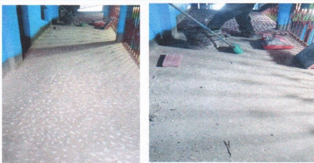
Foto 3: Sustitución de piso de granillo
