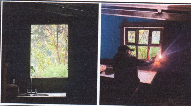
Foto 9: Sustitución de ventanas de madera por metal
