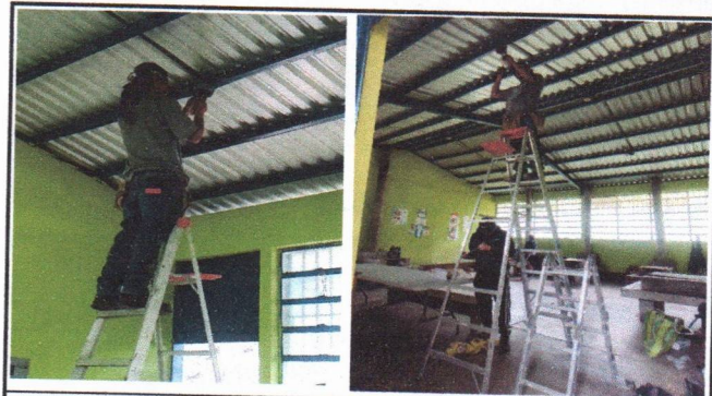
Foto 10: Sustitución de lámparas tipo LED
