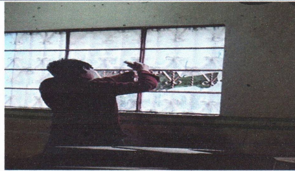
Foto 2: Sustitución de vidrios
