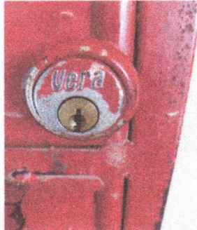
Foto 1: Sustrucción de puerta de madera por metal + sustrucción de chapa
