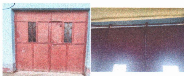
Foto 6: Mantenimiento a porton de metal
