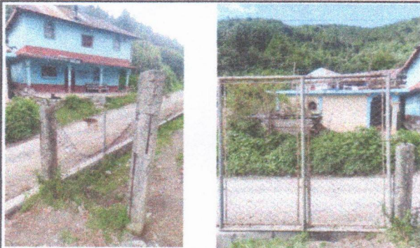
Foto7: Reparación de tubo hg y malla galvanizada
