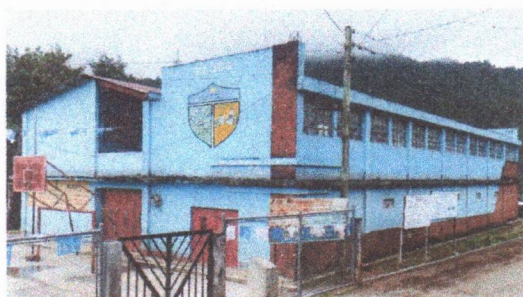
Foto 5: Pintura en muros interiores y exteriores
