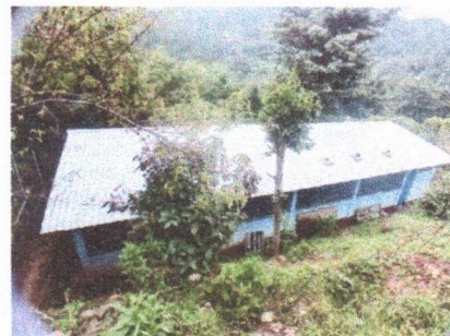
Foto 4: Mejoramiento de canales de metal y bajadas de agua pluvial
