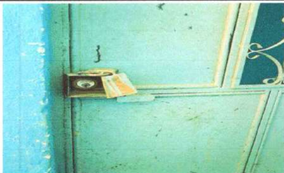
Foto 9: SUSTITUCIÓN DE CHAPAS
