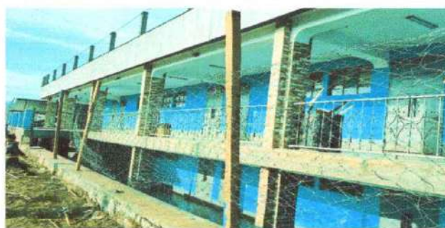
Foto 24: SUSTITUCIÓN DE POSTES DE MADERA POR TUBOS GALBANIZAD, SUSTITUCIÓN DE MALLA, SUSTITUCIÓN DE HIERRO PLANO DE METAL
