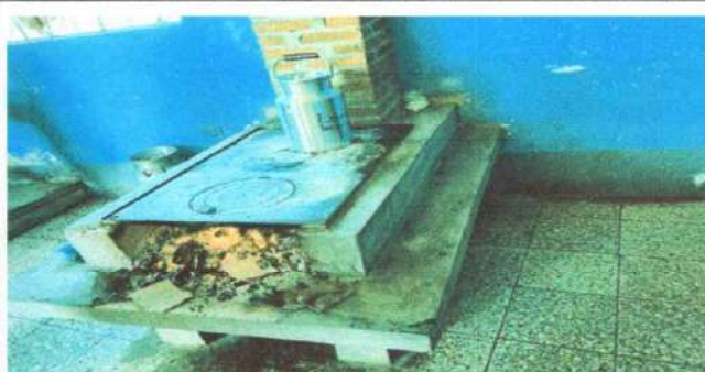
Foto 4: SUSTITUCIÓN DE PLANCHA DE METAL DE TRES HORNILLAS
