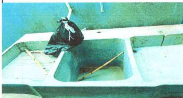
Foto 7: SUSTITUCIÓN DE PILA PEQUEÑA DE CEMENTO CON DOS LAVADEROS
