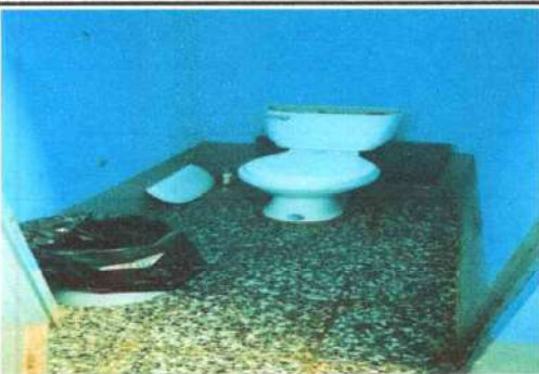
Foto 21: SUSTITUCIÓN DE INODOROS
