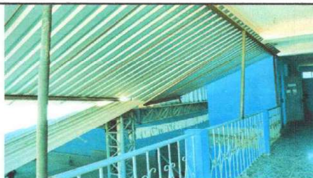
Foto 22: SUSTITUCIÓN DE TUBOS GALBANIZADOS 2X2 PULGADAS, SUSTITUCIÓN DE TUBOS GALBANIZADOS 2X2 PULGADAS
