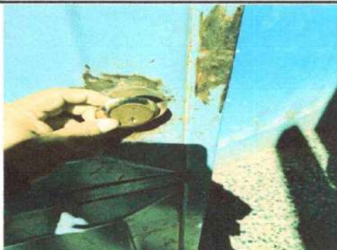
Foto 10: SUSTITUCIÓN DE CHAPAS
