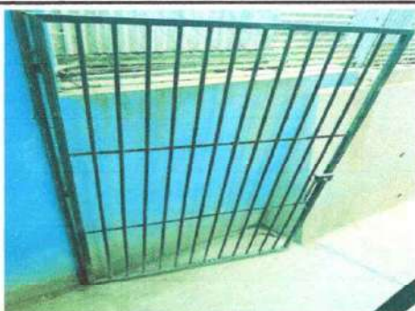
Foto 23: MANTENIMIENTO A ESTRUCTURA PORTON DE REJA (lijado, cambio de tubo, cepillado, sujeciones, aplicación de pintura)
