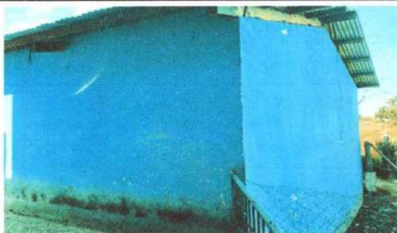
Foto 15: PINTURA INTERNA Y EXTERNA EN LA COCINA
