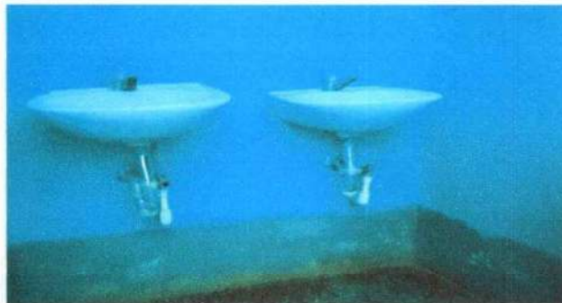
Foto 8: SUSTITUCIÓN DE PILAS DE CEMENTO DE DOS LAVADEROS
