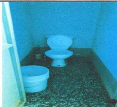
Foto 20: SUSTITUCIÓN DE INODOROS
