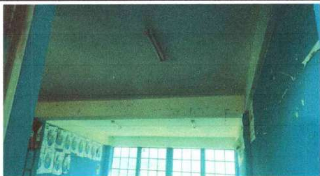
Foto13: SUSTITUCIÓN DE PLAFONERAS, SUSTITUCIÓN DE FOCOS AHORRADORES.
