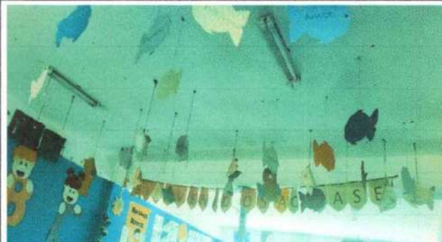
Foto 14: SUSTITUCIÓN DE PLAFONERAS, SUSTITUCIÓN DE FOCOS AHORRADORES.
