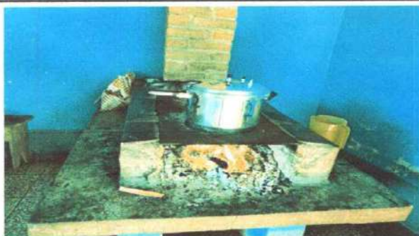
Foto 3: SUSTITUCIÓN DE PLANCHA DE METAL DE TRES HORNILLAS
