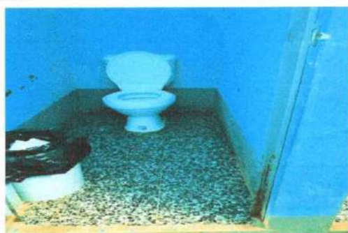
Foto 17: SUSTITUCIÓN DE INODOROS
