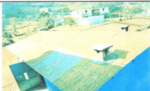
Foto1: SUSTITUCIÓN DE LÁMINA POR LÁMINA TROQUELADA CALIBRE 26, SUSTITUCIÓN DE CAPOTE DE LAMINA PARA LAMINA TROQUELADA, SUSTITUCIÓN DE ELEMENTOS DE FIJACIÓN, SUSTITUCIÓN DE
