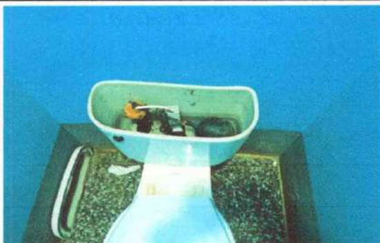
Foto19: SUSTITUCIÓN DE INODOROS
