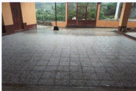
Foto 5: SUSTITUCIÓN DE PISO DE GRANITO
