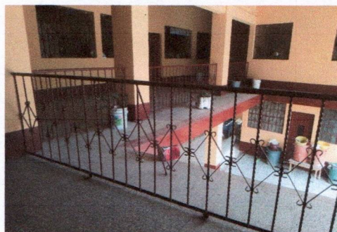
Foto 4: MANTENIMIENTO A BARANDAS DE METAL
