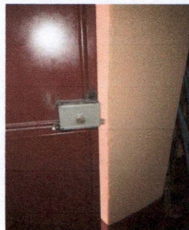
Foto 6: SUSTITUCIÓN DE CHAPAS
