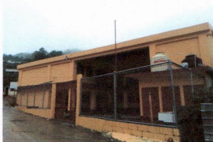
Foto 6: PINTURA EN MUROS EXTERIORES
