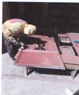
Foto 3: MANTENIMIENTO A ESTRUCTURA (LIJADO, CEPILLADO Y APLICACIÓN DE PINTURA)
