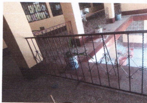
Foto 4: MANTENIMIENTO A BARANDAS DE METAL
