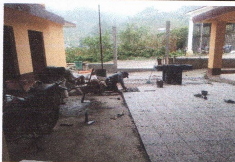
Foto 5: SUSTITUCIÓN DE PISO DE GRANITO
