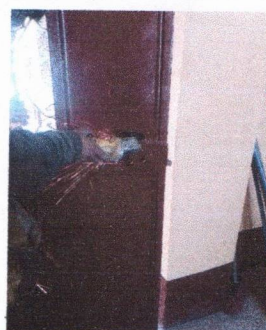
Foto 6: SUSTITUCIÓN DE CHAPAS
