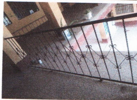
Foto 4: MANTENIMIENTO A BARANDAS DE METAL
