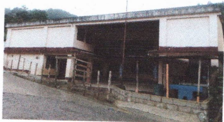
Foto 6: PINTURA EN MUROS EXTERIORES
