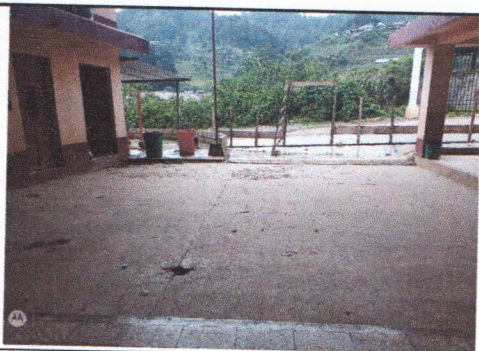
Foto 5: SUSTITUCIÓN DE PISO DE GRANITO
