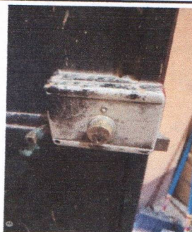
Foto 6: SUSTITUCIÓN DE CHAPAS
