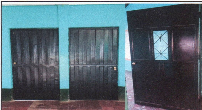
Foto 3: Mantenimiento de puertas por deterioro de pintura y cambio de chapas.
