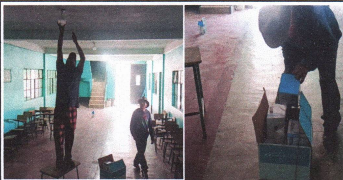
Foto 5: Sustitución de focos ahorrados
