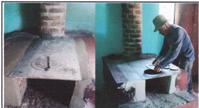
Foto 6: Sustitución de planchas por mal estado.
