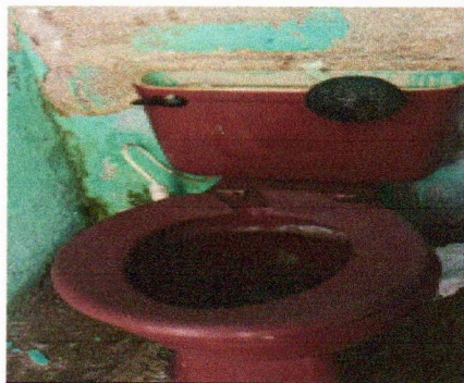
Foto 4: Sustrucción de inodoros por mal estado.
