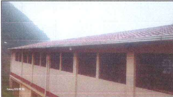
Foto 1: Reparación de canales
