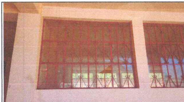
Foto 3: Colocación de balcones de metal
