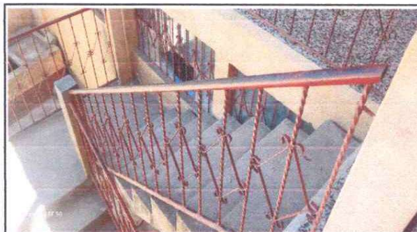
Foto 4: Mantenimiento a barandas de metal
