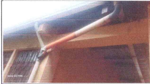
Foto 2: Sustitución de bajada de agua pluvial de PVC3"
