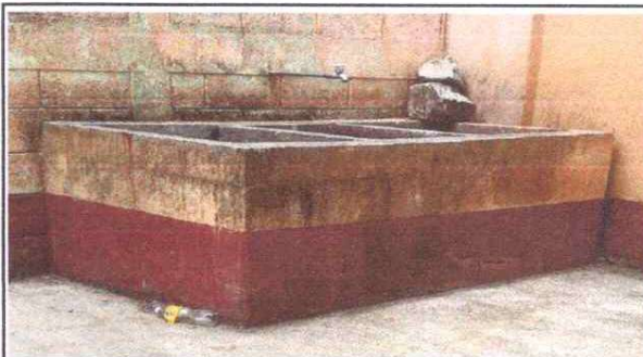
Foto 10: sustrución de pila de cemento de dos lavaderos
