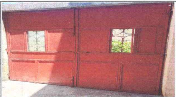
Foto 9: Sustrución de Portón de metal
