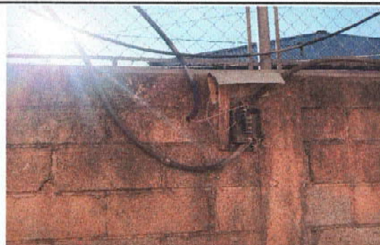
Foto 10: Reparación de sistema eléctrico
