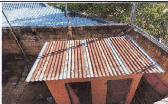
Foto 7: Sustitución de cubierta de lámina
