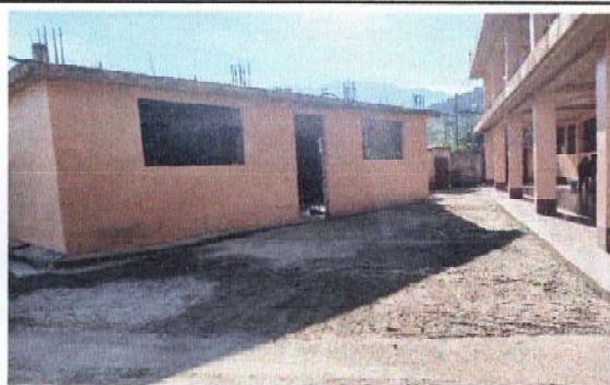
Foto 9: Sustitución de losa de concreto de patio
