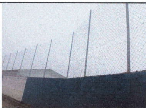
Foto 11: Sustitución de malla y tubos galvanizados
