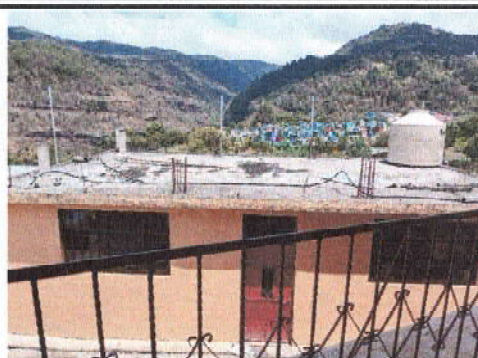
Foto 8: Impermeabilización de losa
