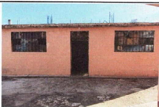
Foto 5: Mejoramiento de balcón y sustitución de vidrios
