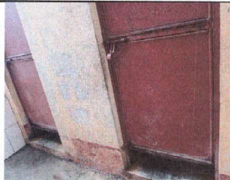
Foto 4: Sustitución de puertas de metal
