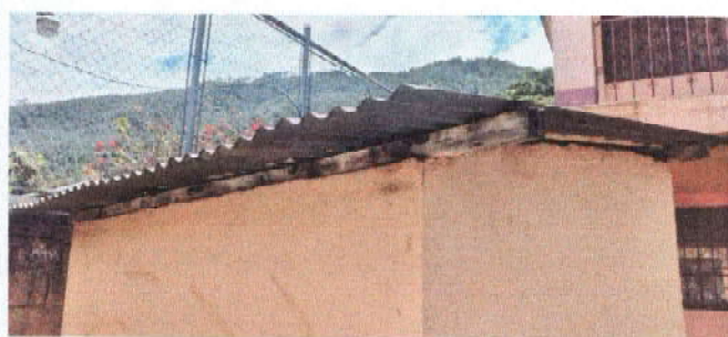
Foto 6: Sustitución de estructura de techo de madera por metal
