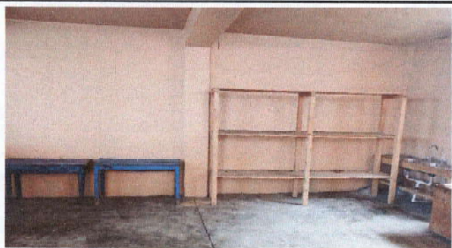
Foto 1: Mejoramiento de mesa, estante y base de lavatrastos de madera por concreto
