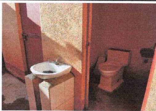
Foto 3: Sustitución de lavamanos e inodoros
