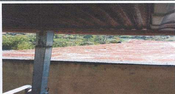
Foto 3: Sustitución de elementos de fijación (Tornillos)
