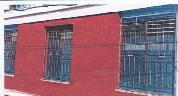
Foto 4: Sustitución de bacones de metal
