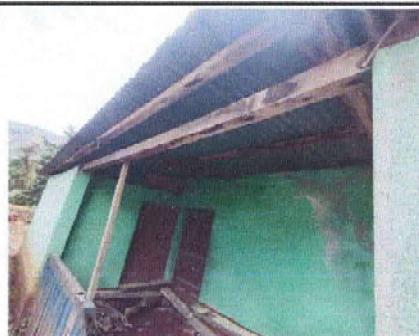
Foto 2: Sustrución de estructura de soporte de madera, por metal en techo de la bodega.
