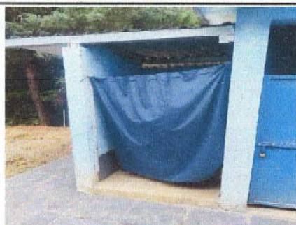
Foto 3: Sustrución de puerta en servicios sanitarios de 1.11X 1.70 metros
