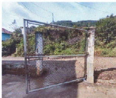
Foto 10: Reparación de columna para portón de metal
