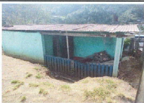
Foto 1: Sustrución de lámina, por lámina troquelada aluzinc callbre 26 en techo de la bodega
