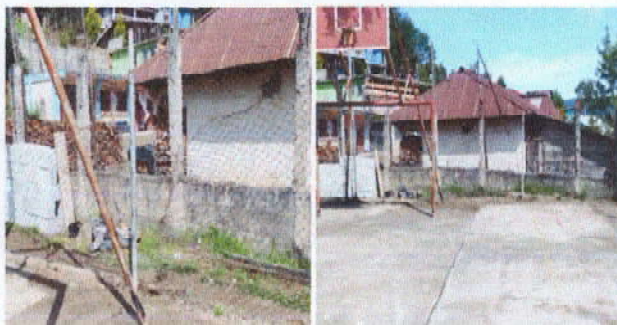
Foto 9: Reparación de tubo hg y malla galvanizada en muro perimetral
