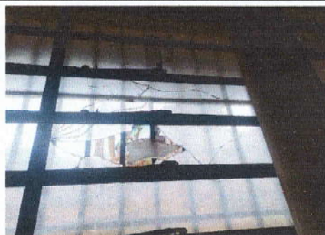
Foto 8: Sustrucción de vidrios .84 X .18 en ventana
