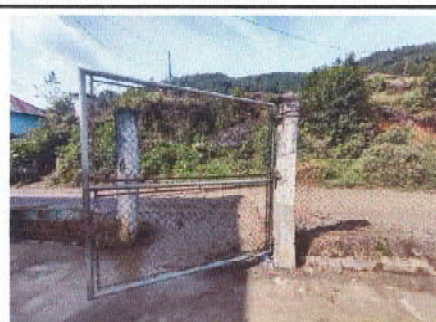
Foto 4: Sustrución de portón de metal de 2.02 x 2.20 metros
