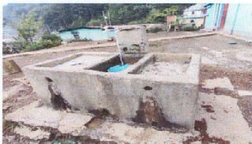
Foto 7: Sustrucción de pla de cemento de dos lavadero
