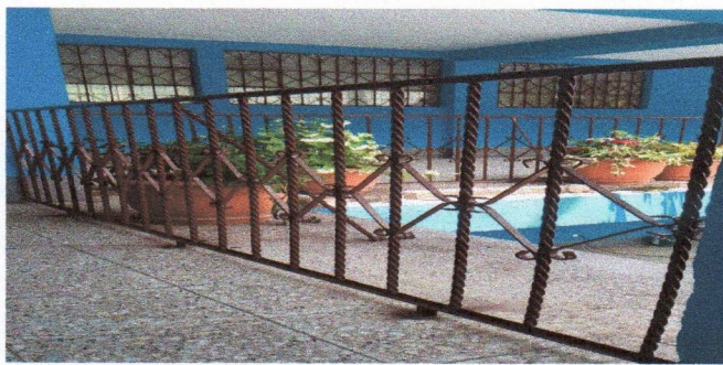
Foto 2: Mantenimiento de barandas lijado y aplicación de pintura
