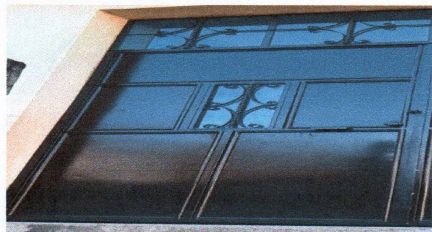
Foto 3: Mantenimiento a estructura ( lijado, aplicación de pintura)
