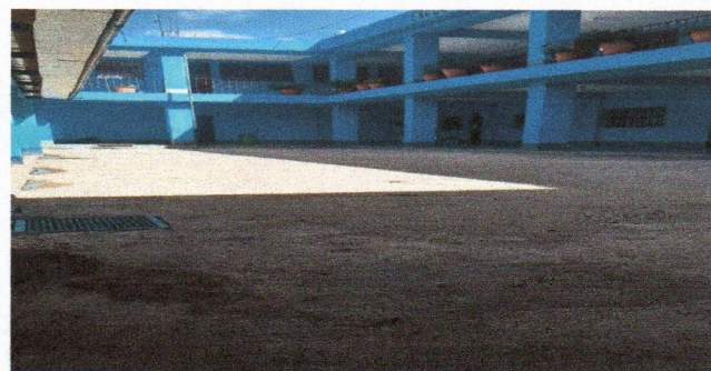
Foto 4: Reparación de planchas de concreto de patio
