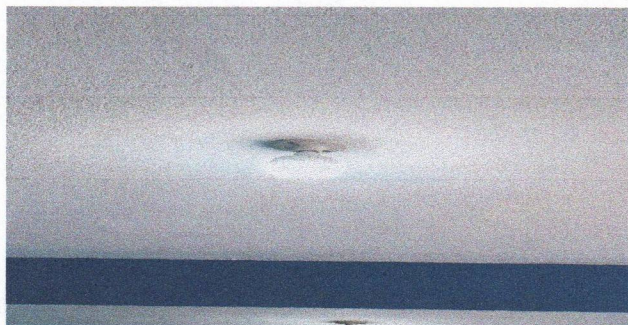
Foto 5: Sustitución de plafoneras
