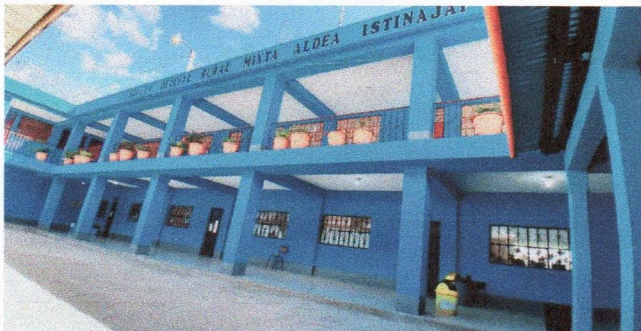
Foto1: Pintura de muros exteriores de la escuela
