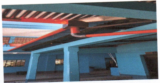
Foto 8: Reparación de bajada de agua pluvial tubo pvc 3
