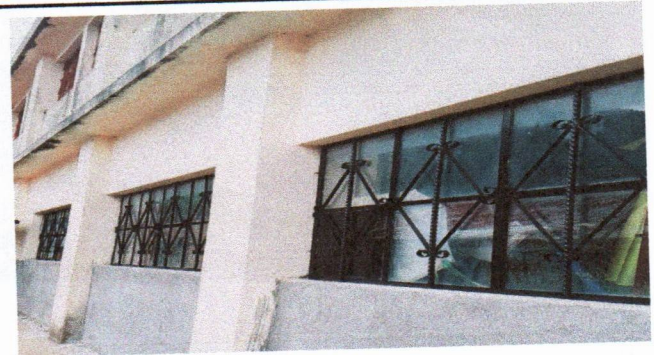
Foto 10: Mantenimiento de estructura de metal de ventana
