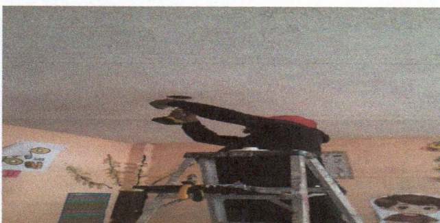
Foto 5: Sustitución de plafoneras
