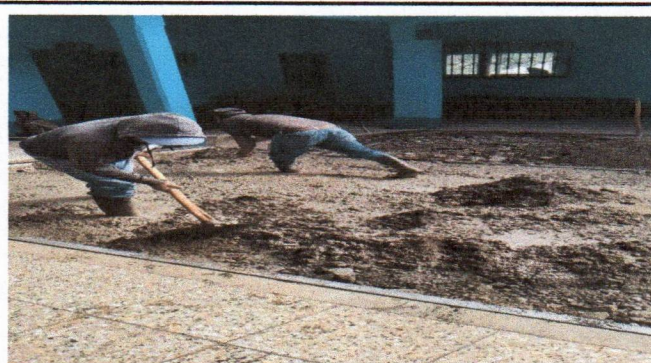
Foto 4: Reparación de planchas de concreto de patio
