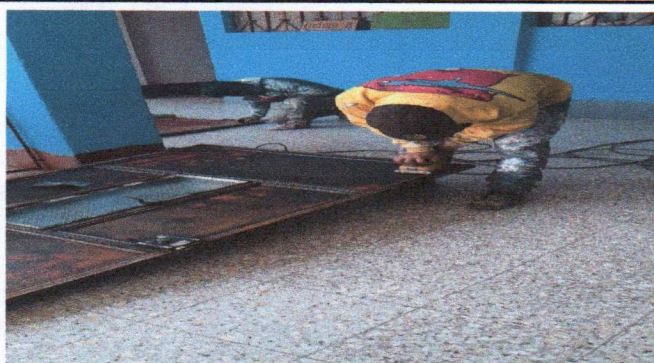
Foto 3: Mantenimiento a estructura ( lijado, aplicación de pintura)
