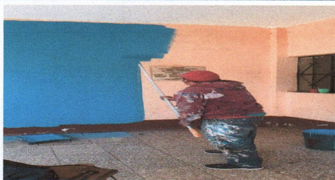
Foto1: Pintura de muros exteriores de la escuela
