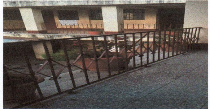
Foto 2: Mantenimiento de barandas lijado y aplicación de pintura
