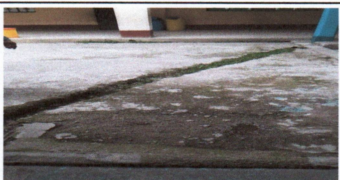
Foto 4: Reparación de planchas de concreto de patio
