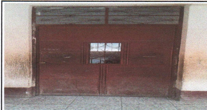
Foto 3: Mantenimiento a estructura ( lijado, aplicación de pintura)
