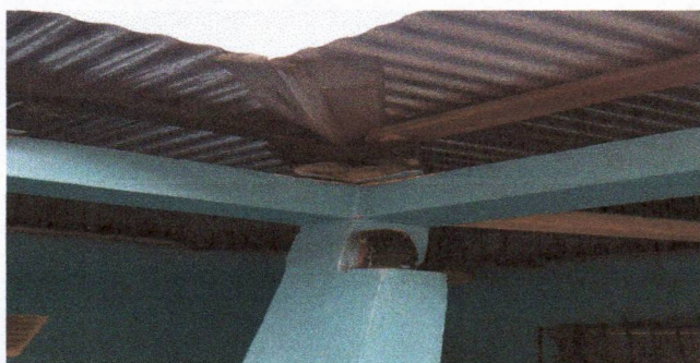
Foto 9: Reparación de bajada de agua
