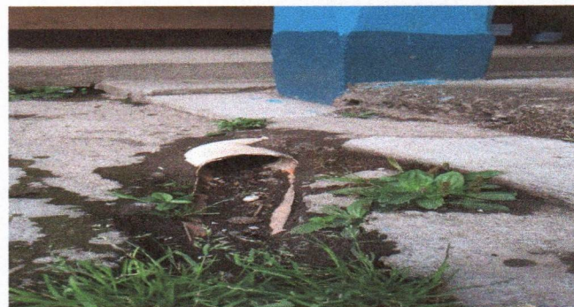
Foto 8: Reparación de bajada de agua pluvial tubo pvc 3
