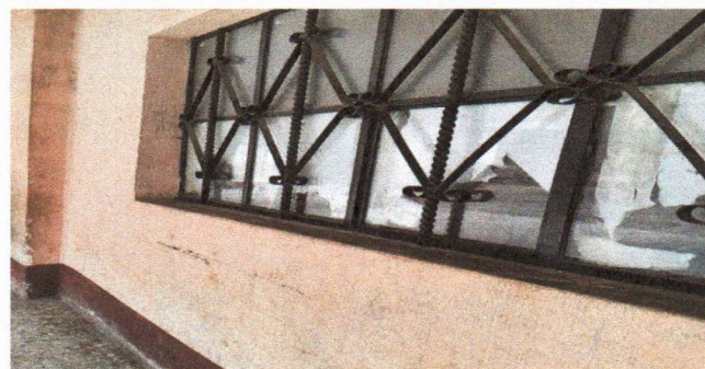
Foto 10: Mantenimiento de estructura de metal de ventana
