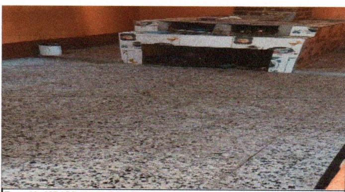
Foto 12: MEJORAMIENTO DE PISO DE TORTA A GRANITO
