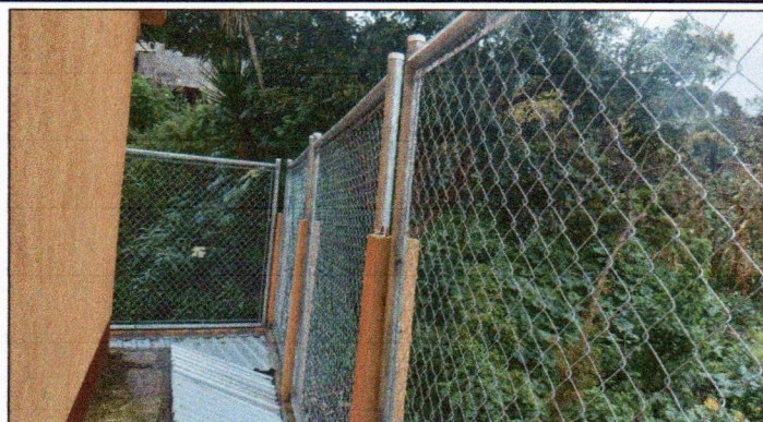
Foto 19: SUSTITUCIÓN DE TAPONES, DE TAPONES DE PVC DE 2 PULGADAS PARA TUBOS GALVANIZADOS
