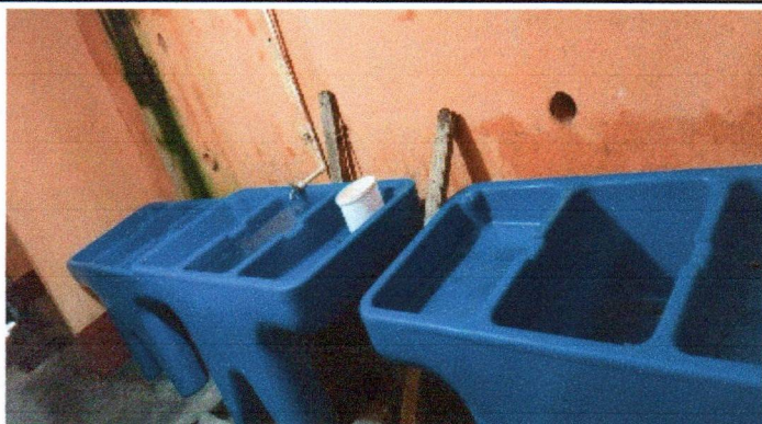
Foto 14: SUSTITUCIÓN DE PILA DE CEMENTO DE DOS LAVADEROS, POR PILAS PLASTICAS DE DOS LAVADEROS
