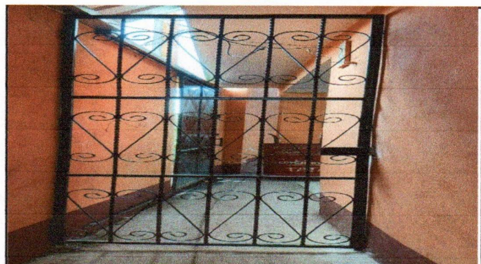
Foto 4: SUSTITUCIÓN DE PUERTA DE MADERA A PUERTA DE METAL.
