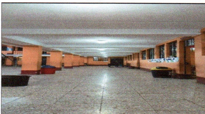
Foto 9: SUSTITUCIÓN DE FOCOS AHORRADORES
