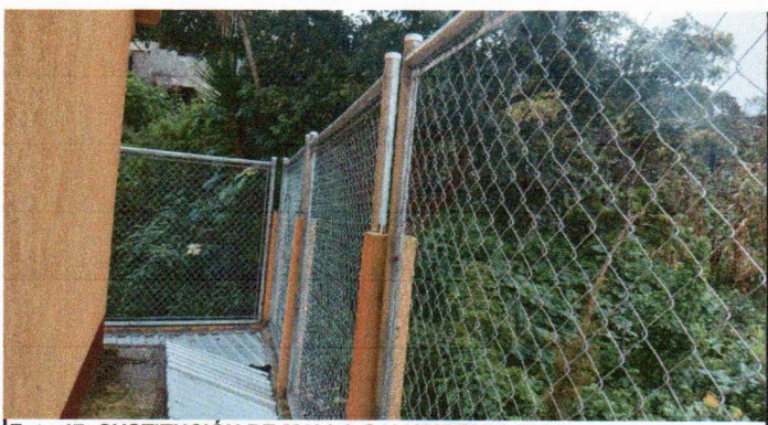
Foto 17: SUSTITUCIÓN DE MALLA GALVANIZADA 2x24 m
