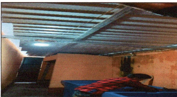
Foto 3: SUSTITUCIÓN DE ESTRUCTURA DE MADERA, POR METAL 2X2 PULGADAS
