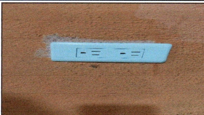
Foto 20: SUSTITUCIÓN DE TOMACORRIENTES DOBLES
