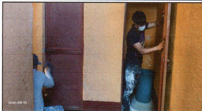
Foto 7: MANTENIMIENTO A ESTRUCTURA( LIJADA, CEPILLADO, SUJECIONES, APLICACIÓN DE PINTURA) A PUERTAS DE SANITARIOS.
