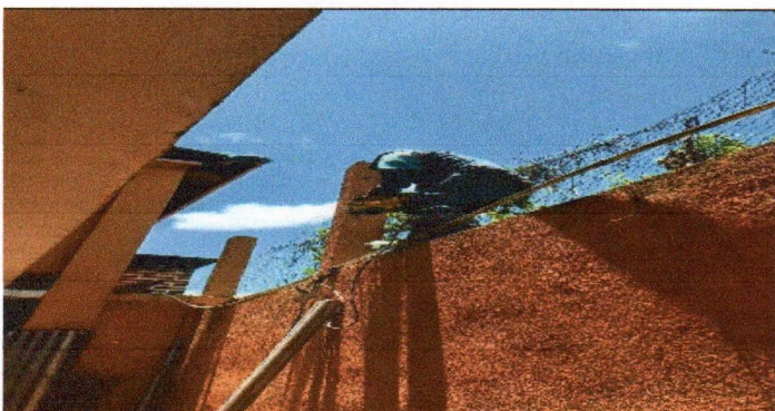
Foto 17: SUSTITUCIÓN DE MALLA GALVANIZADA 2x24 m
