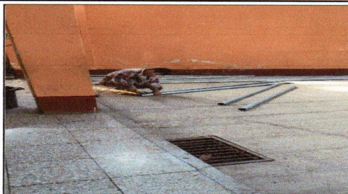
Foto 8: REPARACIÓN DE TUBOS HG
