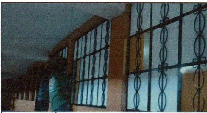
Foto 5: SUSTITUCIÓN DE VIDRIOS
