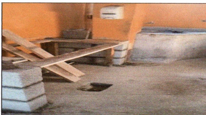
Foto 16: SUSTITUCIÓN DE BASE PARA LAVATRASTOS.
