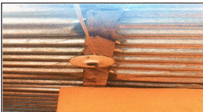
Foto 10: SUSTITUCIÓN DE PLAFONERAS.
