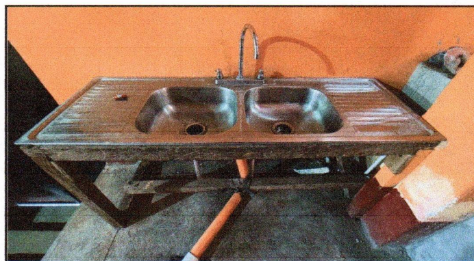
Foto 16: SUSTITUCIÓN DE BASE PARA LAVATRASTOS.
