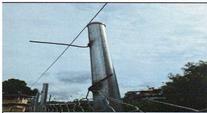
Foto 18: SUSTITUCIÓN DE ELEMENTOS DE FIJACIÓN, HIERROS PLANAS DE 3/4
