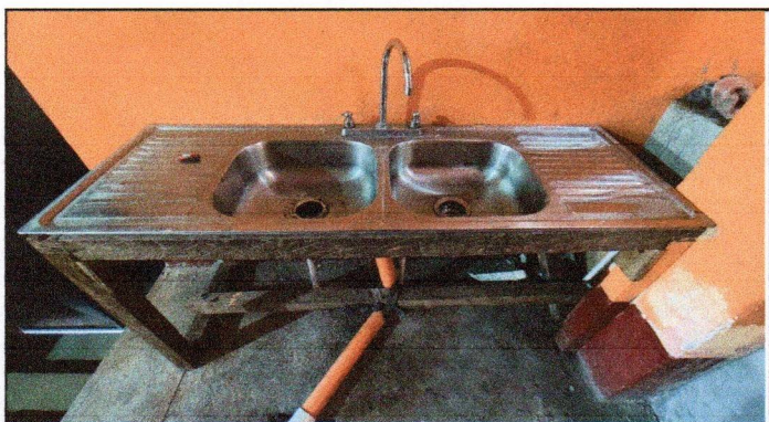
Foto 15: SUSTITUCIÓN DE LAVATRASTO
