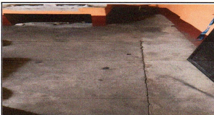
Foto 12: MEJORAMIENTO DE PISO DE TORTA A GRANITO
