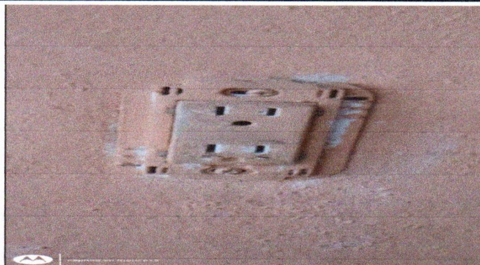
Foto 20: SUSTITUCIÓN DE TOMACORRIENTES DOBLES
