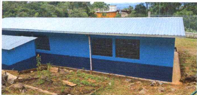
Foto1: Sustitución lámina, por lamina troquelada aluzinc calibre 26 y sustitucion de capote de lamina para lamina troquelada
