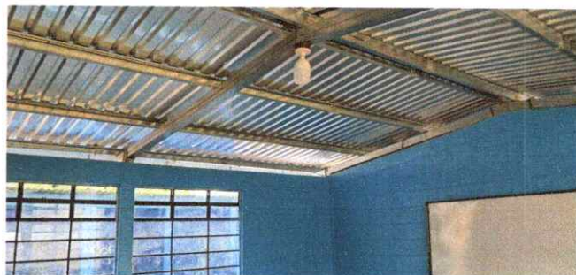
Foto 2: Sustitución de estructura de madera por metal
