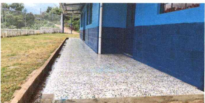
Foto 5: Sustitucion de piso de torta de concreto por piso de granito
