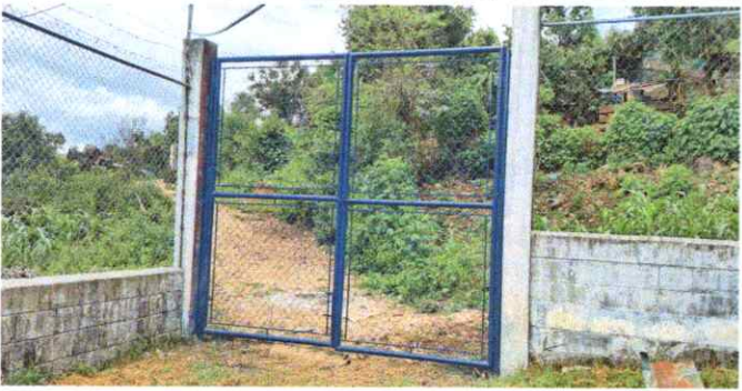
Foto 9: Mantenimiento de pintura a portón de metal de 2.00 m x 1.70 m
