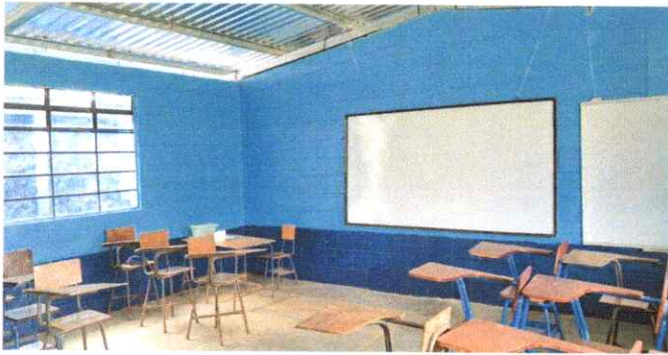
Foto7: Aplicación de pintura en muros interiores
