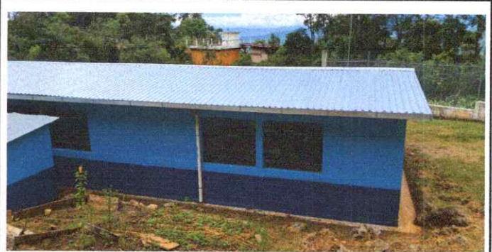
Foto 8: Aplicación de pintura en muros exteriores
