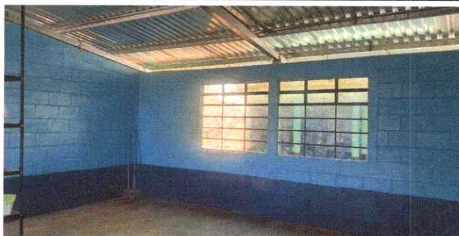
Foto 4: sustitución de vidrios de 50 x 50 centímetros
