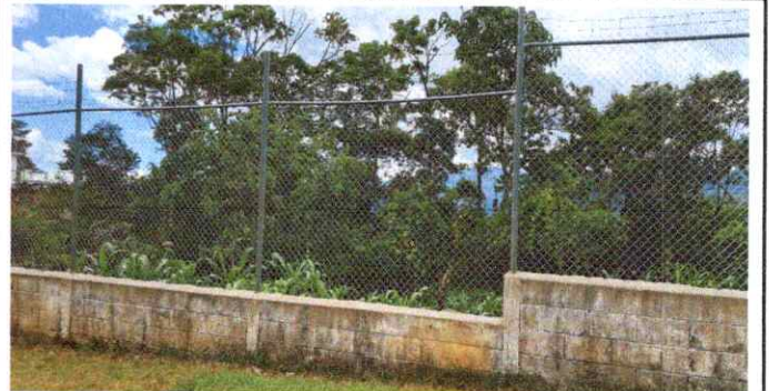
Foto 10: Sustitución de malla galvanizada
