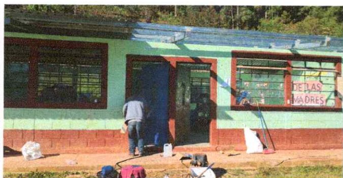
Foto 3: Mantenimiento de puestras y estructura de metal (lijado, sepillado y aplicación de pintura) medidas 2.01 m * 1.01 m
