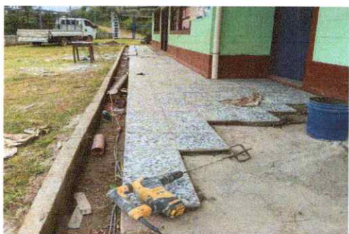
Foto 5: Sustitucion de piso de torta de concreto por piso de granito
