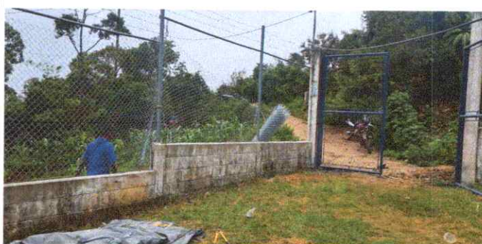
Foto 10: Sustitución de malla galvanizada
