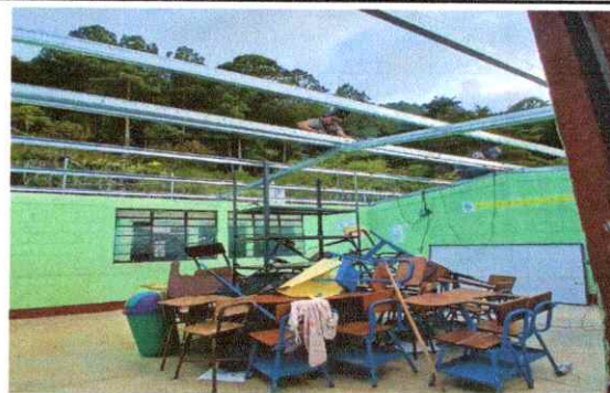
Foto 2: Sustitución de estructura de madera por metal
