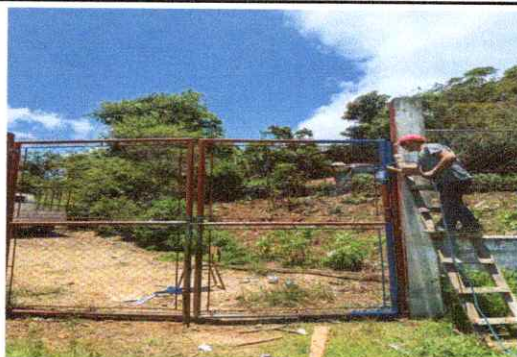
Foto 9: Mantenimiento de pintura a portón de metal de 2.00 m x 1.70 m
