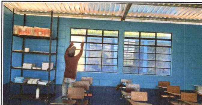
Foto 4: sustitución de vidrios de 50 x 50 centímetros
