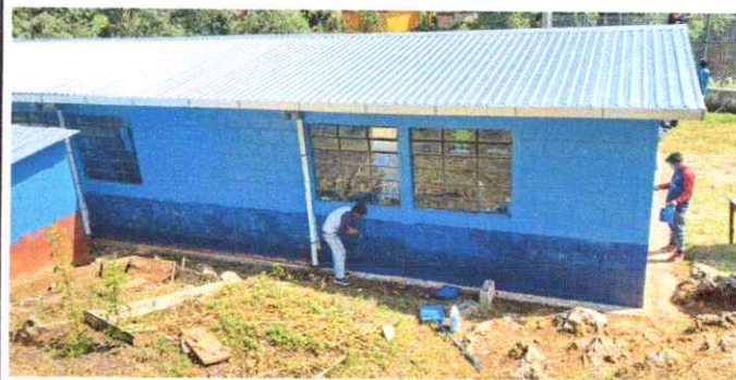
Foto 8: Aplicación de pintura en muros exteriores
