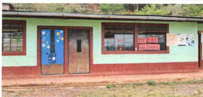
Foto 3: Mantenimiento de puestras y estructura de metal (lijado, sepillado y aplicación de pintura) medidas 2.01 m * 1.01 m
