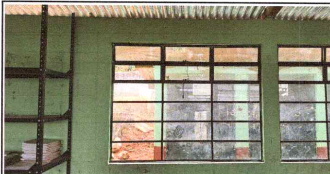
Foto 4: sustitución de vidrios de 50 x 50 centímetros
