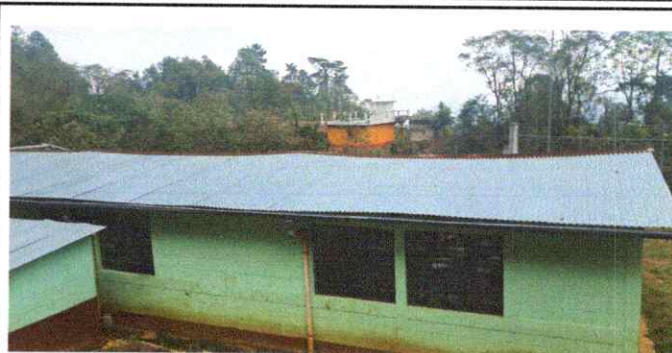
Foto 8: Aplicación de pintura en muros exteriores
