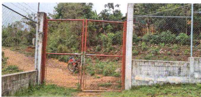
Foto 9: Mantenimiento de pintura a portón de metal de 2.00 m x 1.70 m
