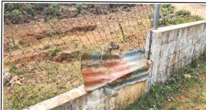
Foto 10: Sustitución de malla galvanizada
