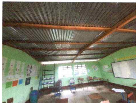
Foto 2: Sustitución de estructura de madera por metal
