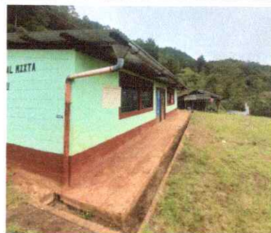
Foto 6: Sustitucion de canales y bajada de agua pluvial
