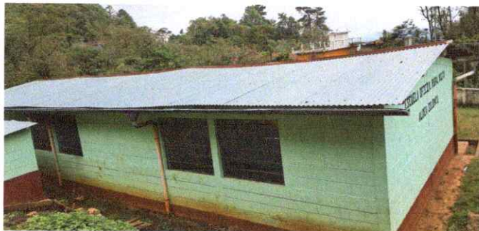
Foto1: Sustitución lámina, por lamina troquelada aluzinc calibre 26 y sustitución de capote de lámina para lámina troquelada
