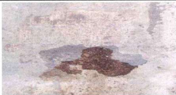
Foto 17: Reparación de plancha de concreto de patio.
