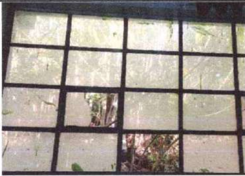
Foto 7: Sustitución de vidrios quebrados.
