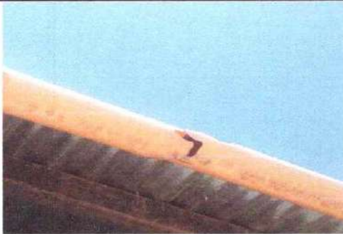
Foto 9: Sustitución de canal de pvc en malas condiciones.
