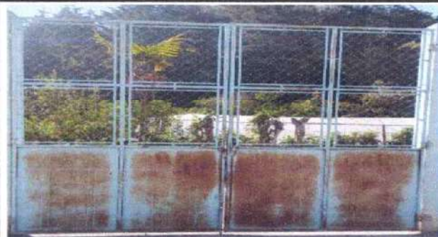
Foto 14: Mantenimiento a portón.
