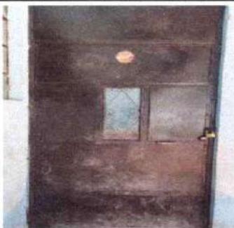
Foto 5: Mantenimiento de estructura de puertas.
