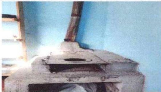
Foto: 19. Sustitución de estufa rural completa.
