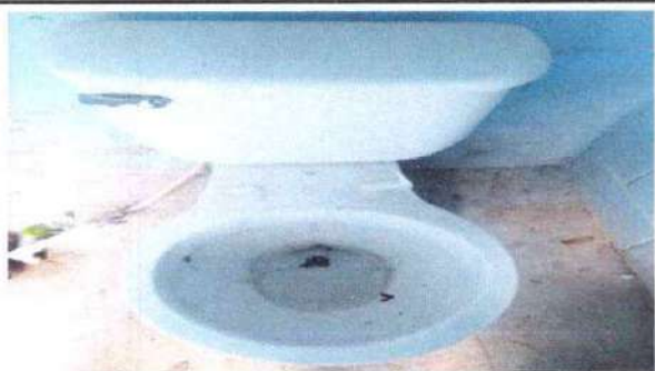
Foto 13: Sustitución de tapaderas sanitarias.
