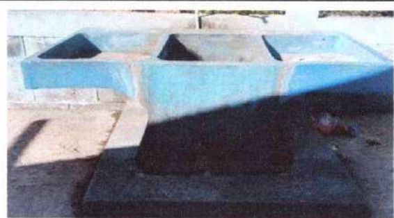
Foto: 20. Sustitución de pila de dos lavaderos.
