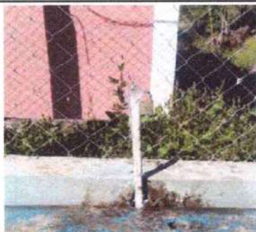
Foto 15: Sustitución de chorro.
