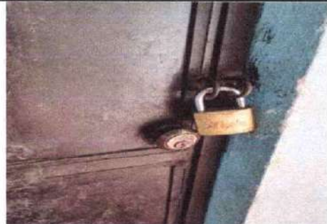
Foto 6: Sustitución de chapa.
