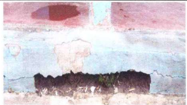
Foto 10: Reparación de banqueta.
