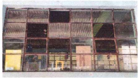
Foto 8: Mejoramiento de ventanas con balcones de metal.
