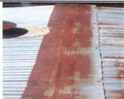
Foto 2: Sustitución de capote de lámina por mal estado.
