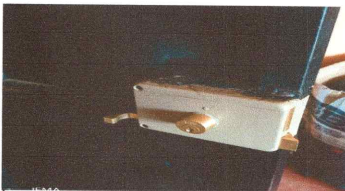
Foto 4: Sustrución de chapa
