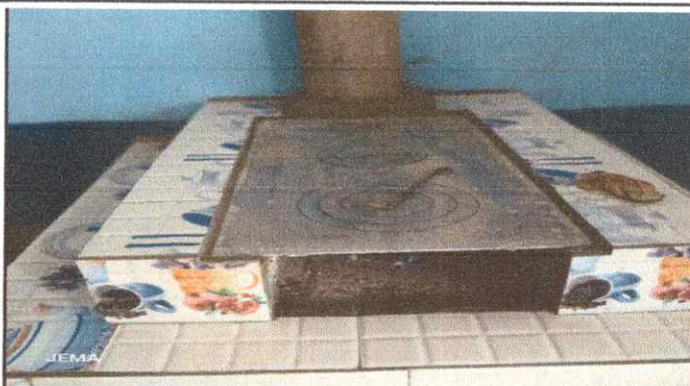
Foto 14: Instalación de azulejo en estufa rural
