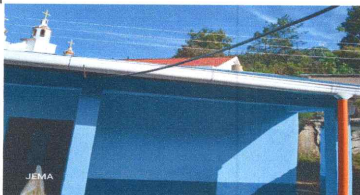
Foto 9 :Sustrucción de canal de pvc
