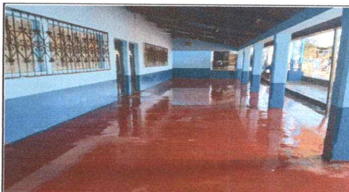
Foto 10: Pintura en muros exteriores e interiores
