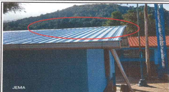
Foto 2: Sustrución de capote de lámina para lámina troquelada
