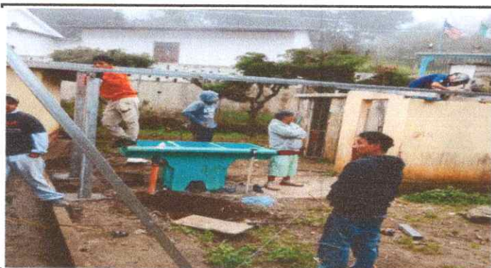
Foto 15: Sustitución de pila de cemento de dos lavadero
