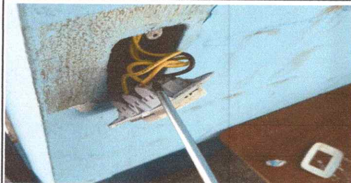
Foto 13: Sustitución interruptores dobles
