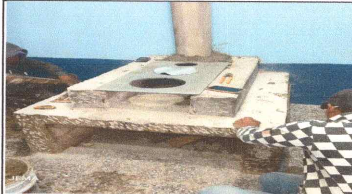
Foto 14: Instalación de azulejo en estufa rural
