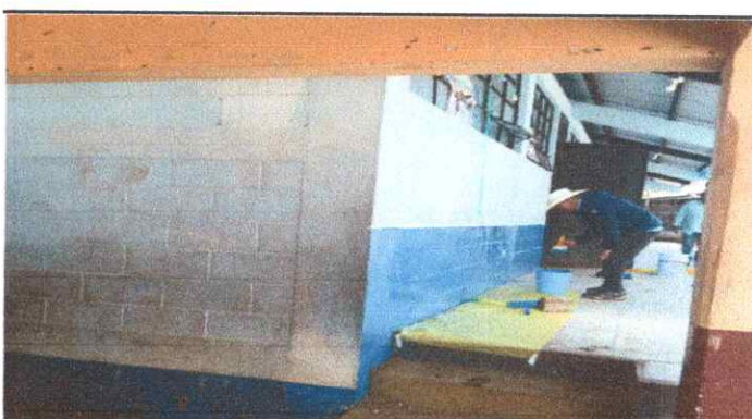
Foto 10: Pintura en muros exteriores e interiores
