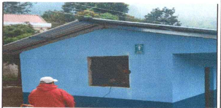
Foto 6: Sustitución de ventanas de madera por metal mas vidrio 1Mx1M
