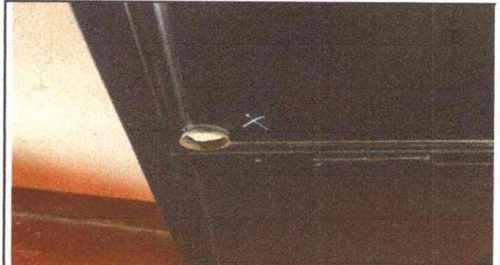
Foto 4: Sustitución de chapa
